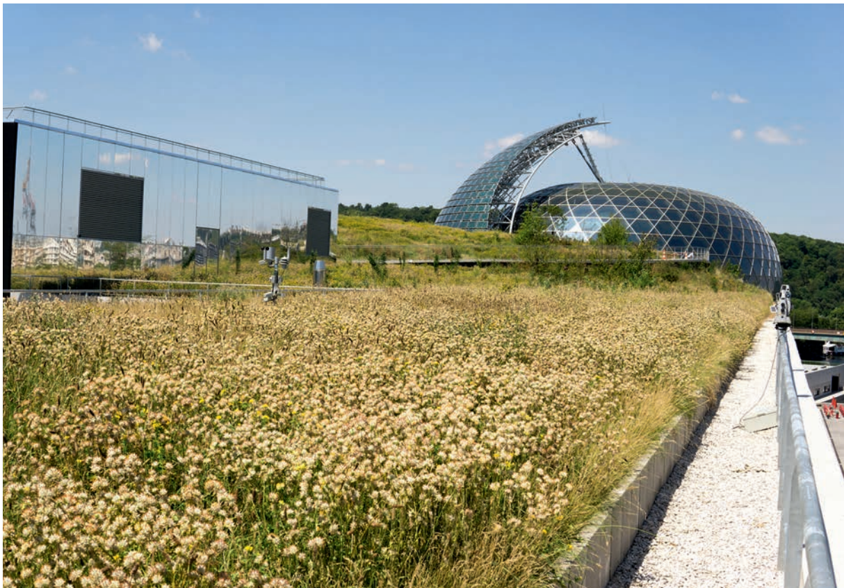
La toiture de la Seine musicale à Boulogne-Billancourt a une capacité de rétention en eau d'environ 184 L/m 2 © Audrey Muratet | ARB idF
