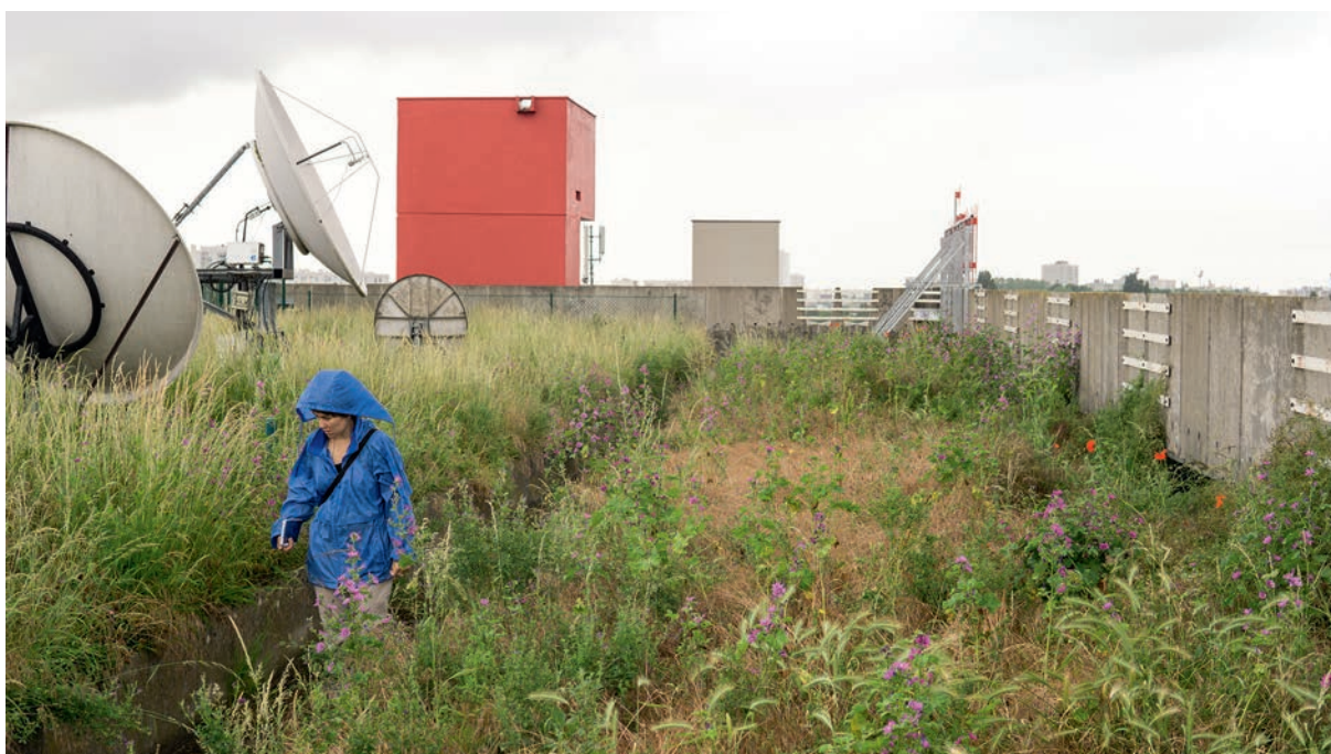
Les conditions climatiques et hydriques influencent la capacité de rafraîchissement des toitures végétalisées. Bâtiment logistique dit « Mozinor » à Montreuil © Audrey Muratet | ARB îdF
