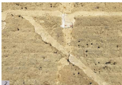
1 : Ancienne dépendance d'une ferme - Saint-Étienne-sur-Chalaronne (01). 2 : Détail d'une maçonnerie en pisé de terre. 3 : Principe de construction d'un mur en pisé de terre. 4 : Coupes de principe d'une ancienne ferme en pisé - Messimy-sur-Saône (01).
