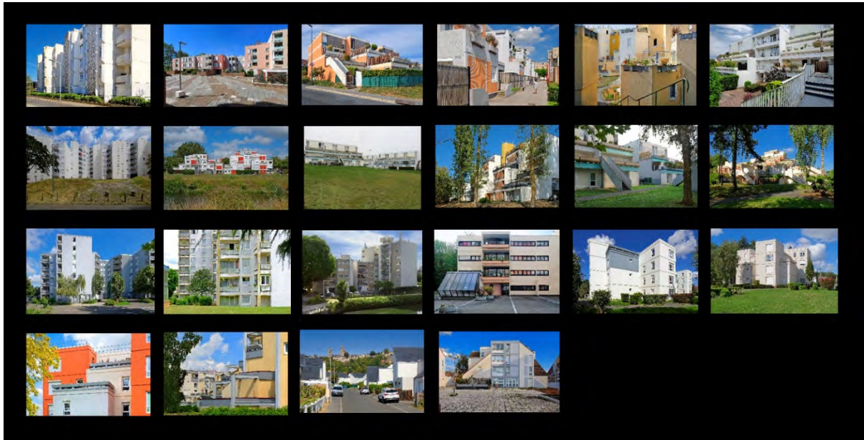
Sélection des 22 opérations pour une présentation à la commission régionale du patrimoine et de l'architecture (CRPA). Photos Vincent Lecigne, 2020.
