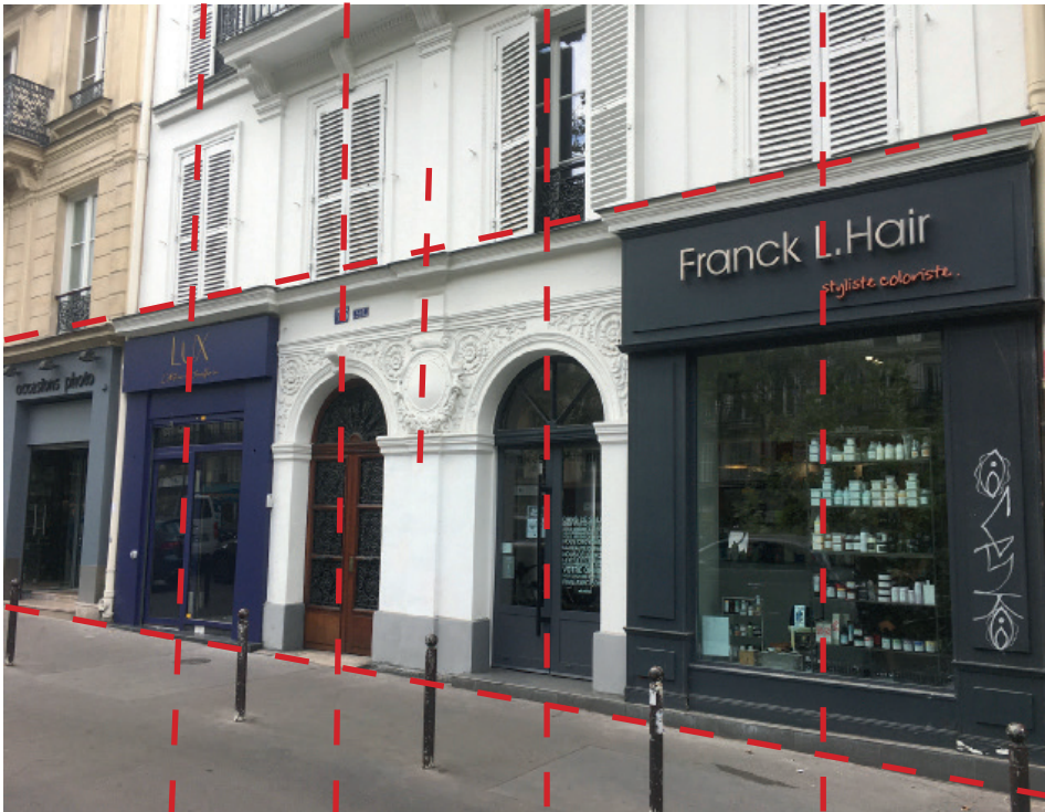
Les devantures respectent la symétrie et l'axe de composition de l'immeuble, et s'imbriquent dans la composition d'ensemble en intégrant les entrées des immeubles.
