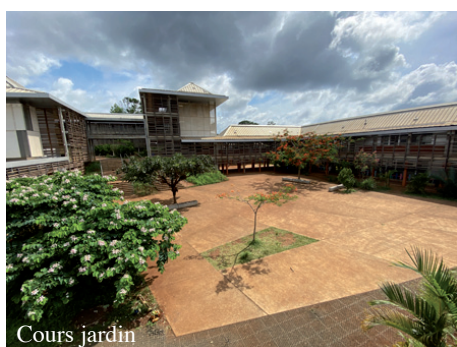
Protection des façades
