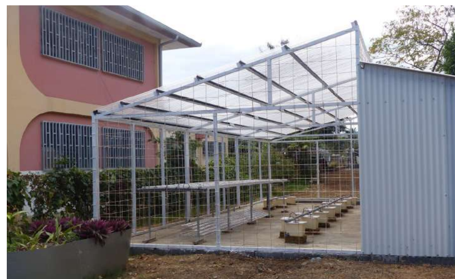
Serre expérimentale aquaponique en construction dans la Micro-ferme urbaine du Port
