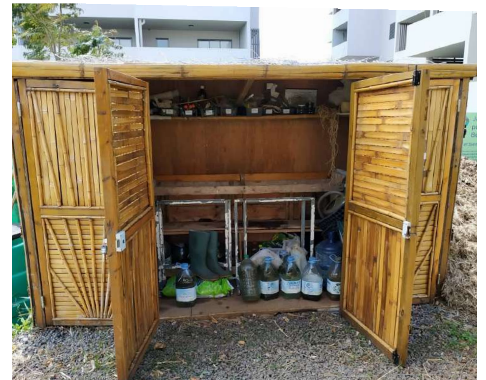
Cabane à outils du Jardin permacole de Beauséjour construite avec du bambou, matériau produit localement et anciennement utilisé dans la construction.
