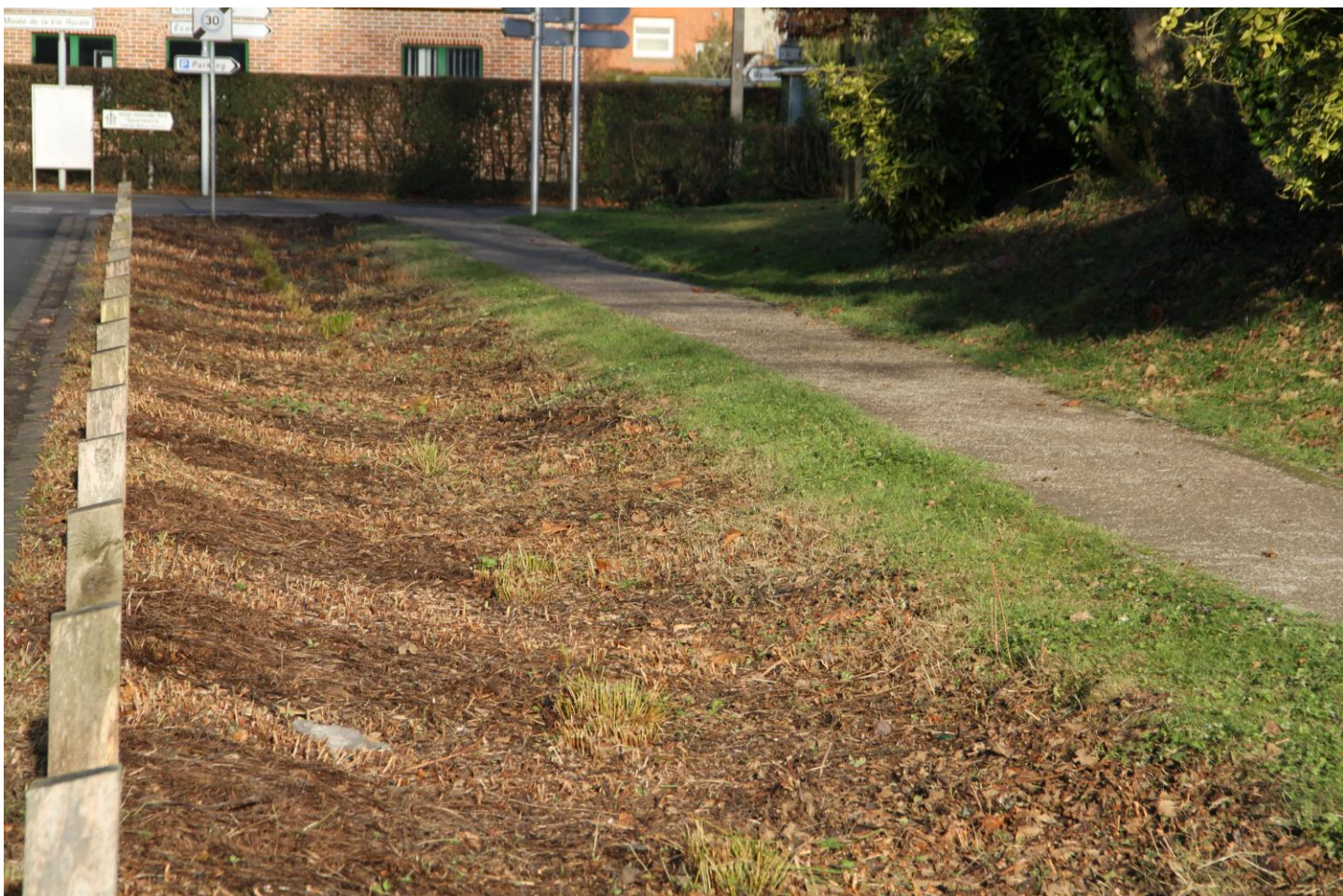
(Noue dans le centre de Steenwerck)
