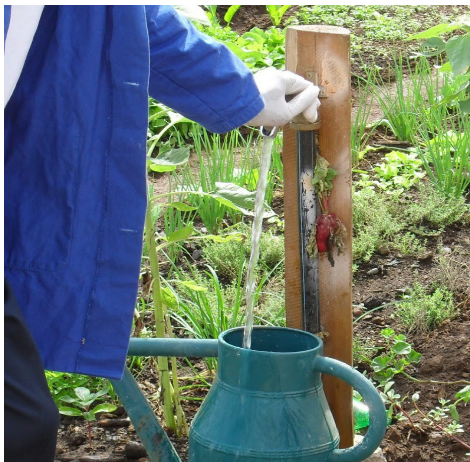
Récupération d'eau raisonnée grâce au robinet poussoir
