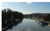
Canal latéral creusé de l'Oise - Noyon (60) - ©CAUE60
