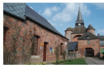
Eglise fortifiée – Perfontevall (02) – ©CAUE02
