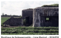
Blockhaus de Godevaersvelde – Ligne Magnot – ©CAUE59
