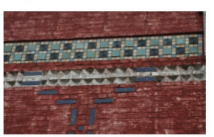
Détail architectural – Beaumetz-lès-Cambrai (62) ©CAUE02
