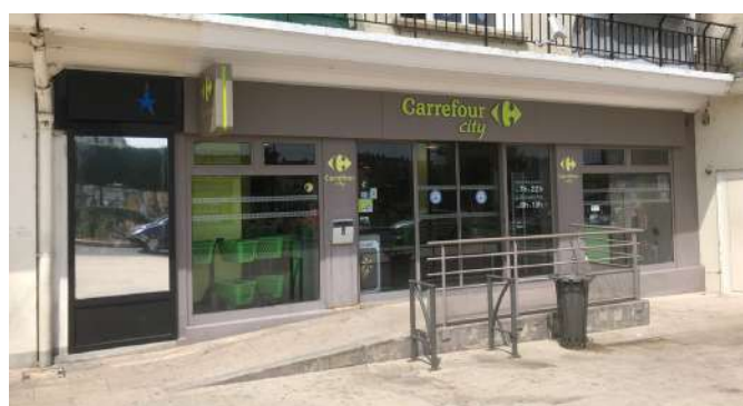
Rampe d'accès PMR
