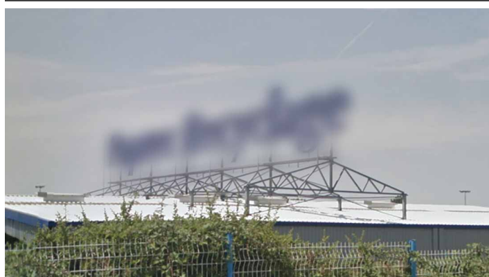
Enseigne publicitaire bleue se reflétant sur la tôle blanche du bâtiment. Source : CGSatellite - La TeleScop.
