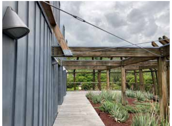
Toiture terrasse accessible au niveau des combles
