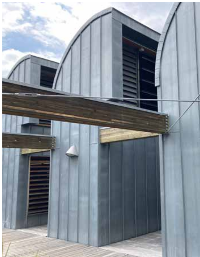
Ecopes de cheminées de ventilation en zinc au niveau des combles
