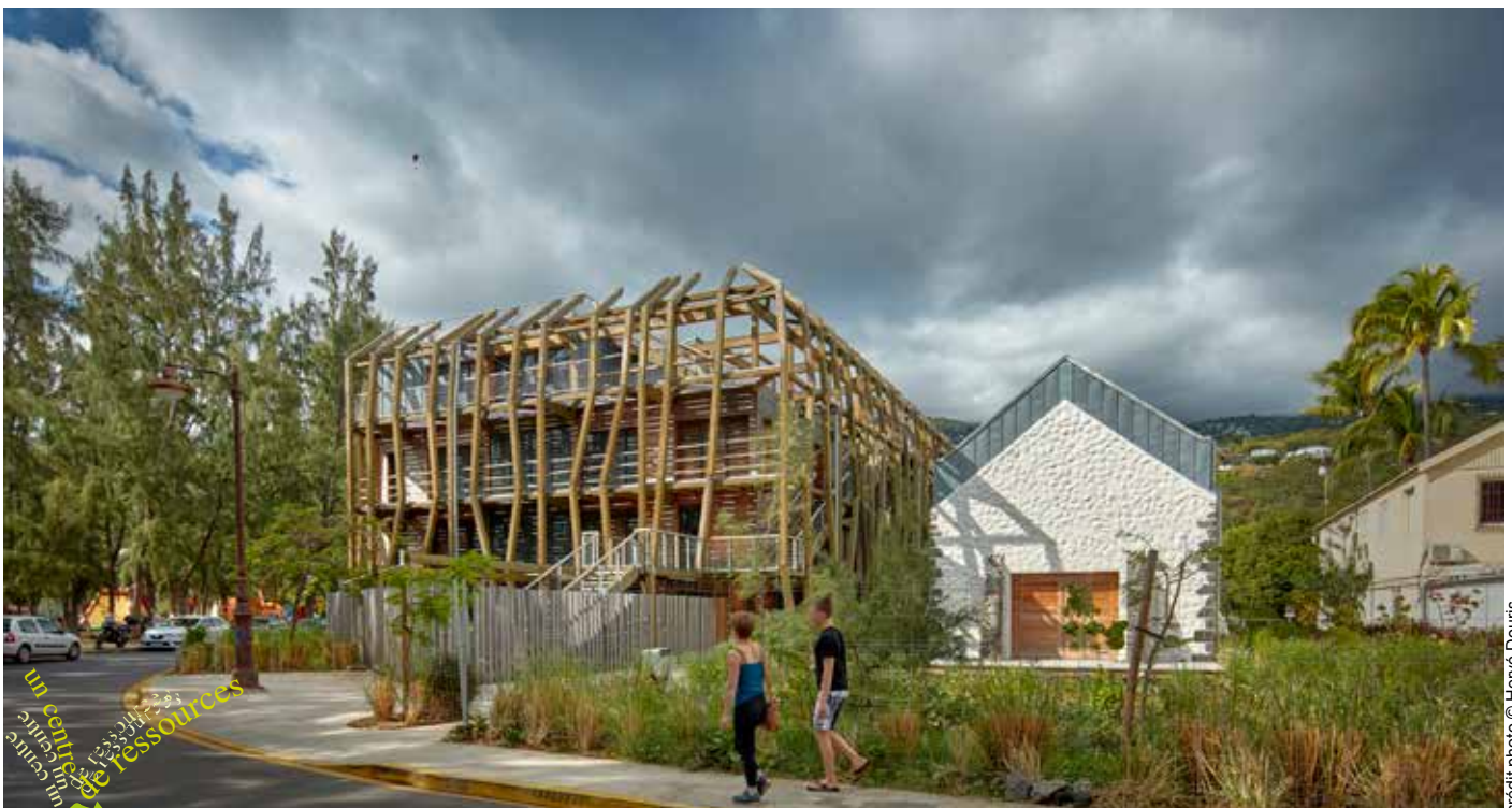
Ensemble médiathèque et auditorium dans l'environnement du bord de mer / végétalisation des abords
