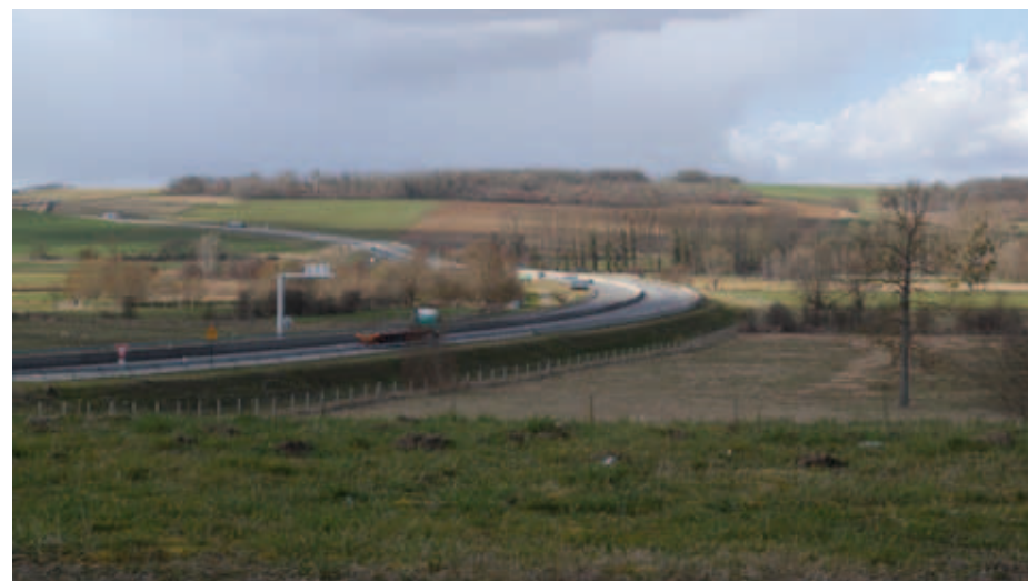
Le contournement de Saint-Clair-sur-Epte sur la RD 14, aux abords dégagés et légèrement en surplomb du terrain naturel, permet de jouir du paysage de la vallée de l'Epte.
