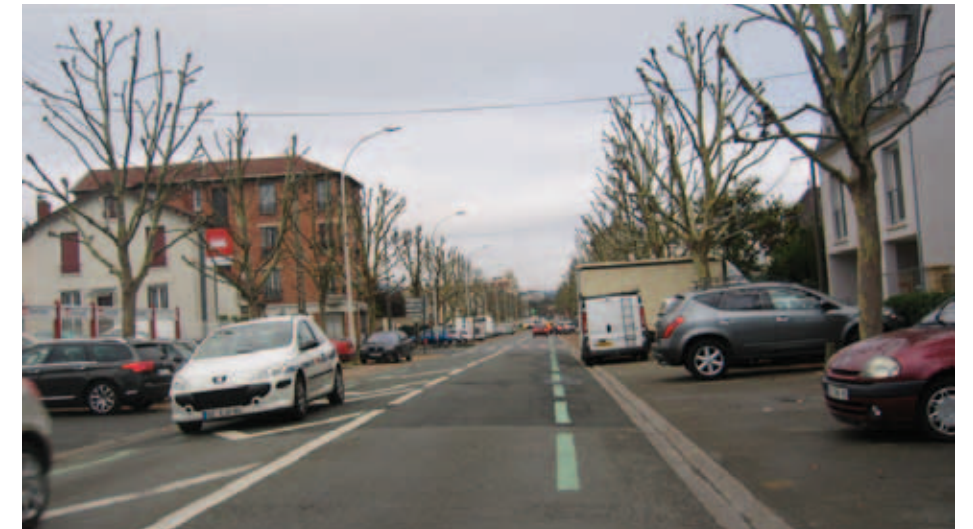
La RD 14, à hauteur de l'entrée de ville de Sannois a conservé son double alignement de platanes aujourd'hui encore structurant. La requalification de cet axe avec un vocabulaire de voirie urbaine, une plus grande attention aux motifs de façades, aux continuités et à l'orientation des bâtis restaurerait sur ce secteur une image de ville plus lisible.
