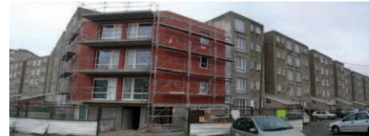
La densification des tissus urbains concerne aussi l'habitat collectif. Le motif d'angle urbain redessine l'îlot dans le projet de renouvellement urbain du quartier des Doucettes à Garges-Lès-Gonesse.
