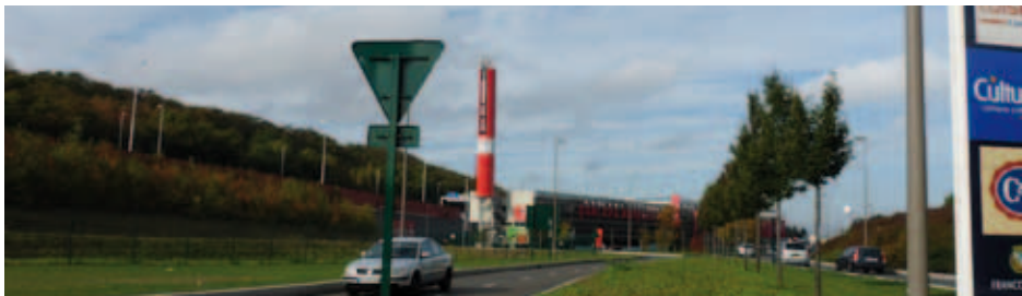
L'édifice commercial se profile dans la continuité du socle de l'A 15. Ensemble, ils organisent une figure d'architecture du paysage.
