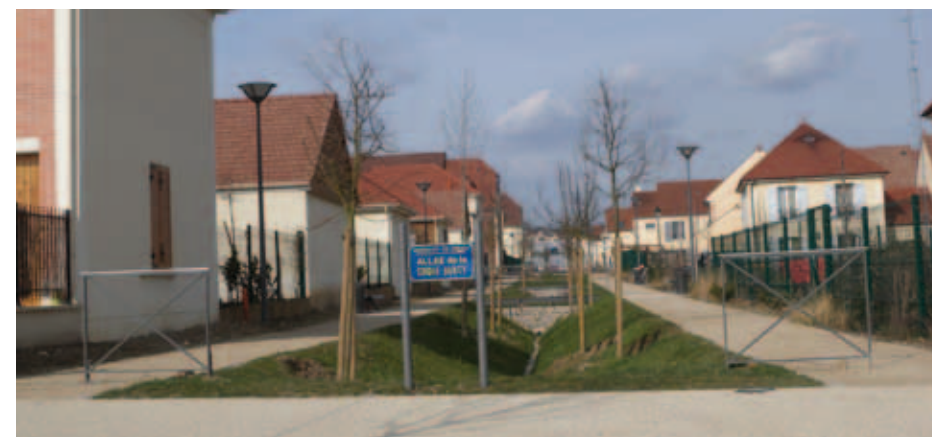
Noue enherbée à Cormeilles, à proximité de la ZI du Val d'Argenteuil. Cette méthode alternative de gestion des eaux pluviales permet d'améliorer les capacités de rétention et d'infiltration des sols, et de profiter de la présence de l'eau pour accompagner les liaisons douces du quartier. Le cadre de vie s'en trouve amélioré, les nuisances dues aux épisodes de crues décennales ou centennales sont évitées.
