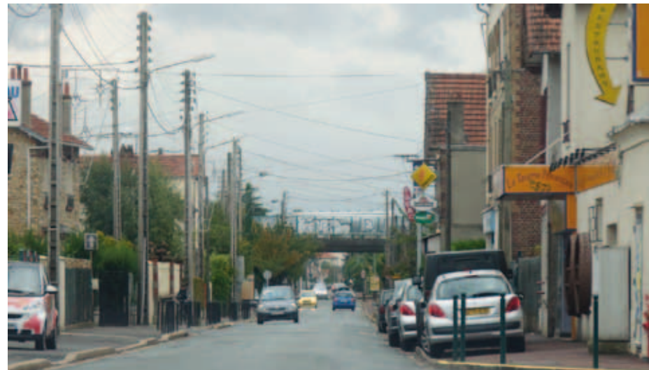
La chaussée Jules César entre les gares d'Ermont et Franconville pâtit d'un alignement de bâtis hétéroclites et de réseaux aériens qui n'aident pas à sa lisibilité. Une attention particulière devrait être portée à la qualité des façades. Ici les maisons en meulière dénotent une qualité particulière en contraste évident avec des constructions de tout style. Les écrans antibruit de l'ouvrage en viaduc de l'A 115 gagneraient à être requalifiés.
