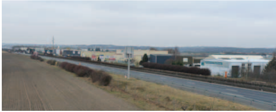
L'autoroute A 15, à hauteur d'Herblay. Les séquences de zones d'activité jusqu'à Cergy-Pontoise deviennent de plus en plus nombreuses. Les fronts bâtis indifférenciés des zones d'activité banalisent le paysage de l'infrastructure et forment un écran entre la route et le paysage de la ville.
