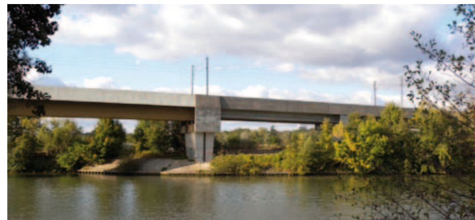
Viaduc du RER A à Eragny. Cet ouvrage d'art de franchissement de l'Oise, à hauteur de Cergy-Pontoise n'opère pas de coupure et offre des points de vue, contrairement à une ligne souterraine.
