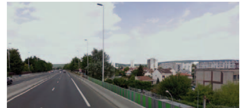
L'A115 survole la ville à hauteur des toits. Les murs anti-bruit occultent cette perception et l'image de modernité dégagée par cette autoroute urbaine et aérienne.
