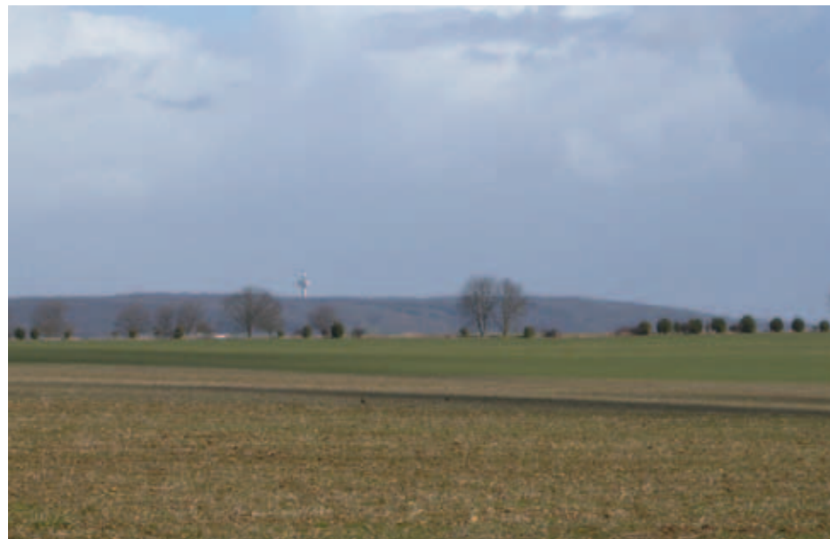
Située dans l'Oise, la tour télécom du bois de la Molière n'en constitue pas moins une balise pour la perception du territoire du Val-d'Oise. Les points hauts des buttes attirent les regards et les équipements, les moulins d'autrefois, aujourd'hui les relais de transmission. Un œil exercé peut reconnaître ces signes distinctifs, identifier ainsi les buttes qu'ils supportent et trouver des repères balisant le territoire.
