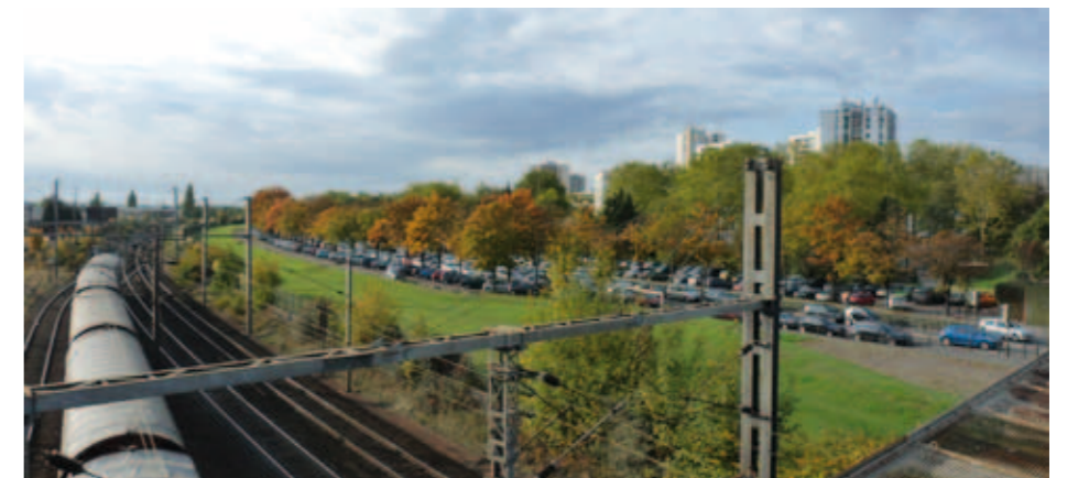
Voies ferrées à proximité du val d'Argent. Malgré une emprise et des nuisances bien moindres que celles d'une autoroute, les quatre voies parallèles et leurs câbles provoquent une coupure visible et difficilement franchissable.
