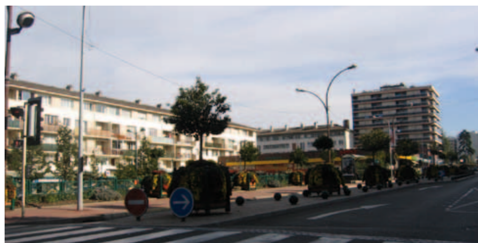
Franconville illustre une volonté déjà ancienne de conjuguer des immeubles d'habitat collectif avec un espace de centralité illustrée par les récents aménagements paysagers, de fleurissement et de mobilier.
