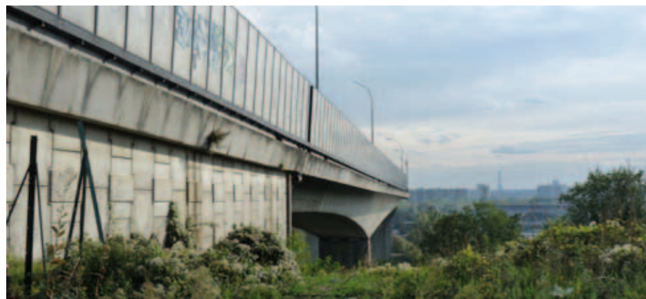
Une dimension impressionnante de l'ouvrage d'art de franchissement de la Seine. A hauteur d'Argenteuil, l'A 15 se profile dans la direction de Paris.
