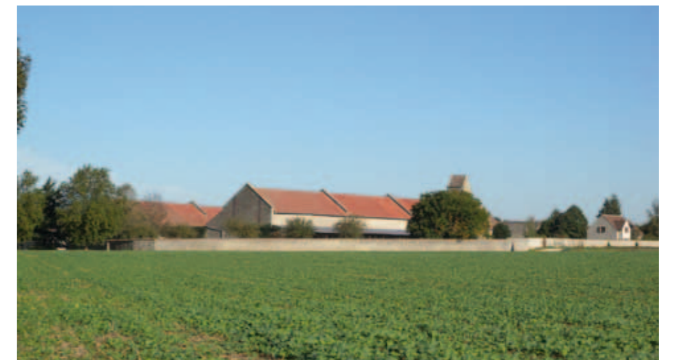
Le mur du jardin marque une limite franche sur les cultures, articulation affirmée qui assoit le volume de la bâtisse sur le plateau.
