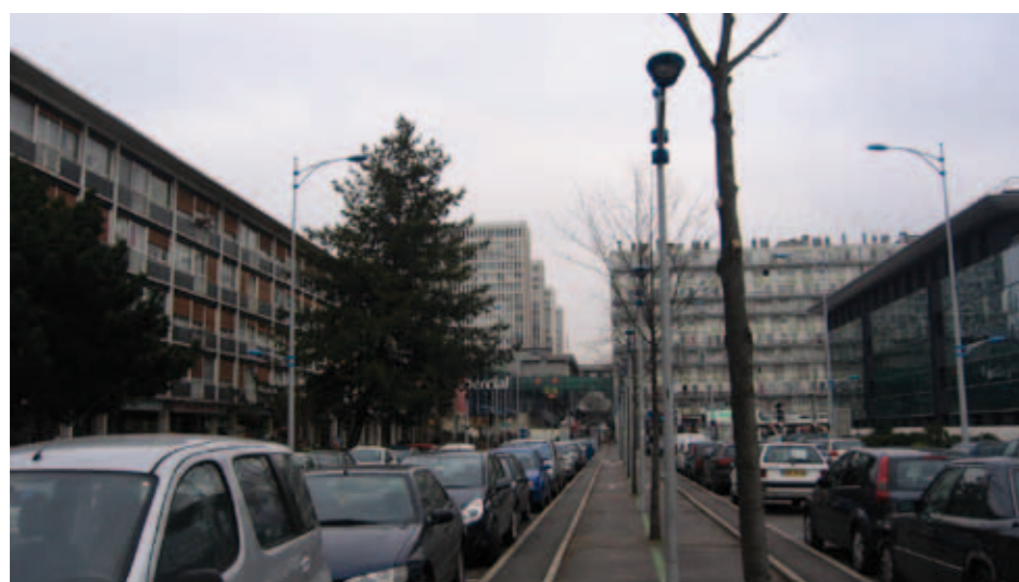
L'opération de Sarcelles Grand Ensemble commence en 1954 et se termine en 1976. Durant cette période, les partis-pris architecturaux et urbanistiques évoluent : densification du bâti - y compris dans des quartiers déjà construits -, abandon des principes fonctionnels au profit du retour de la rue, trame urbaine constituée d'îlots urbains qui s'organisent autour de deux axes principaux renouant ainsi avec la composition des villes traditionnelles en opposition aux cités monofonctionnelles. Malgré le terme de « sarcellite » qu'il inspira à partir de 1962, Sarcelles fut une expérience pionnière qui est encore aujourd'hui une leçon d'urbanisme.
