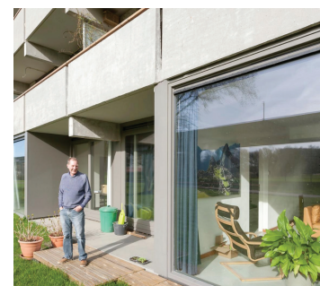
Les rez-de-chaussée aménagés en logements
