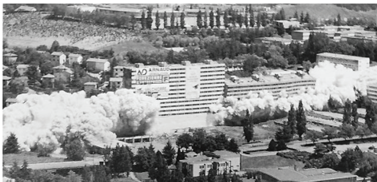
Jour de démolition de la « muraille de Chine » à Saint-Etienne
