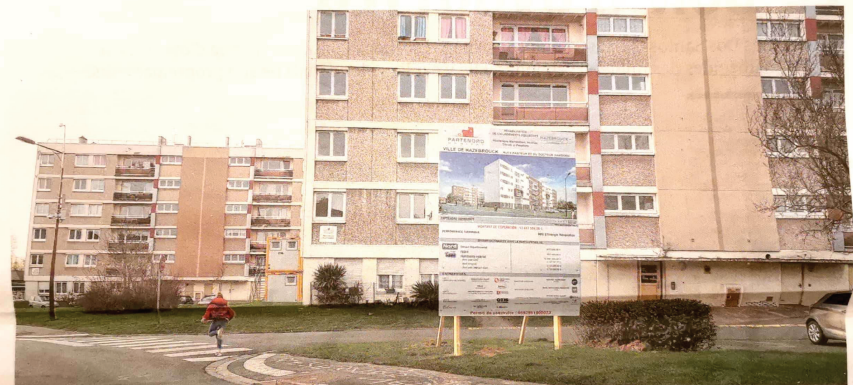
Quatre des cinq résidences du quartier seront rénovées. La cinquième, Platanes, sera détruite.
