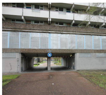
La route intérieure située au R+1
