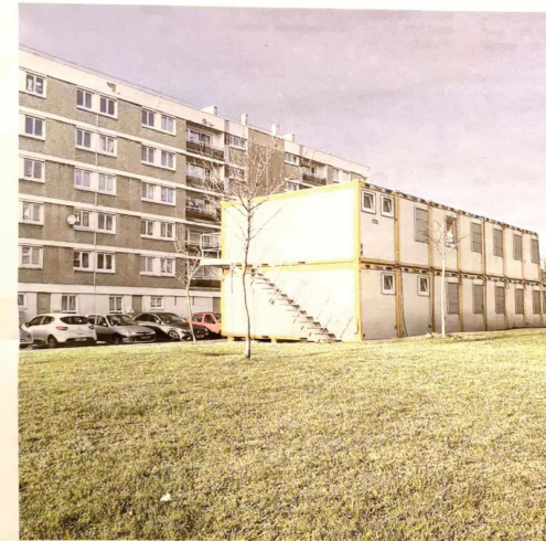
Une base vie de chantier a été installée en bordure de parking derrière les Platanes.
