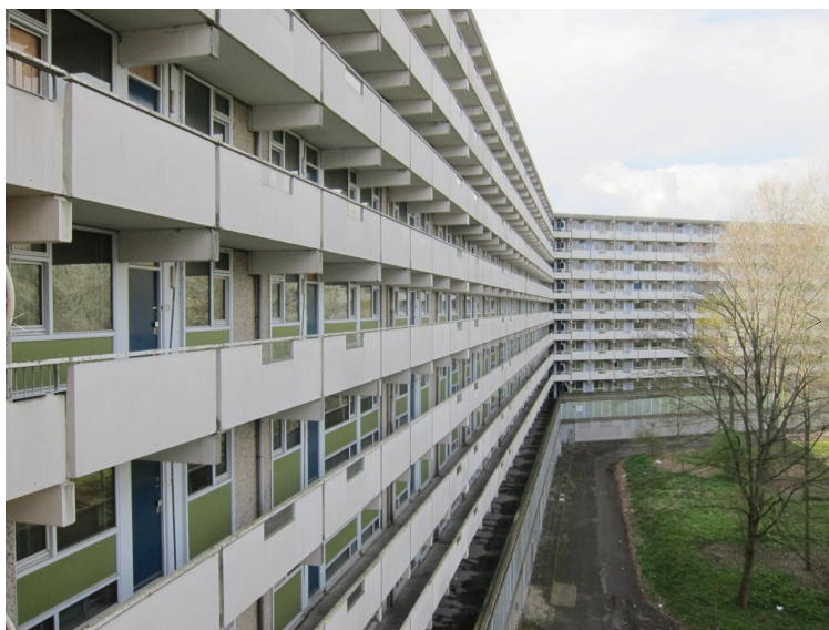
La barre du Kleiburg avant réhabilitation
