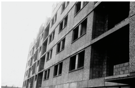
Le quartier Pasteur-Foch d'Hazebrouck en construction en 1958
