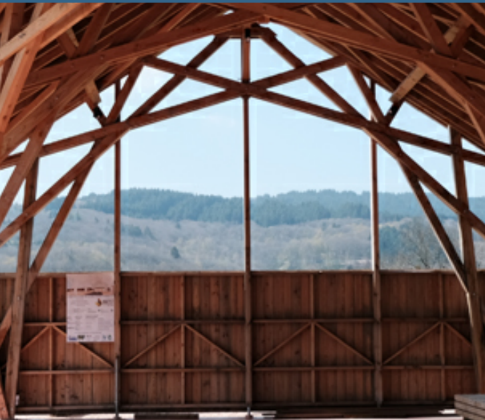
Halle à Anost (71), Atelier Correia arch., photo CAUE 71
