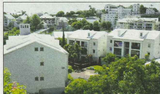
55% des communes de La Réunion n'ont pas assez de logements sociaux. (Photo P.N.)
