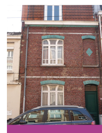
Façade d'étude – détaillée en annexe
