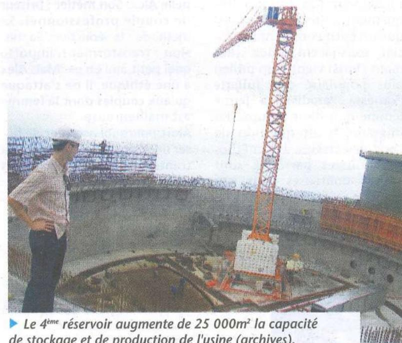
► Le 4<sup>ème</sup> réservoir augmente de 25 000m<sup>3</sup> la capacité de stockage et de production de l'usine (archives).
