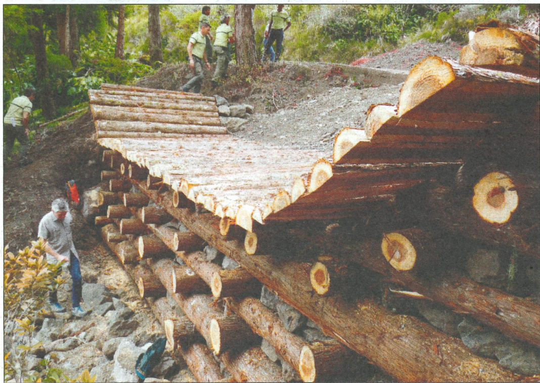
L'ouvrage qui pèse 80 tonnes s'étend sur 11 mètres de large. (Photos A.D.)
