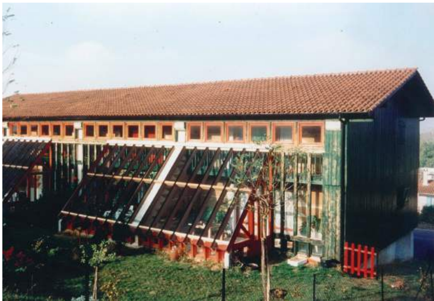
Îlot B, façade sud : les murs Trombe sont associés à des ouvertures basses et hautes permettant de diffuser les calories accumulées dans la serre au sein de l'habitation.
