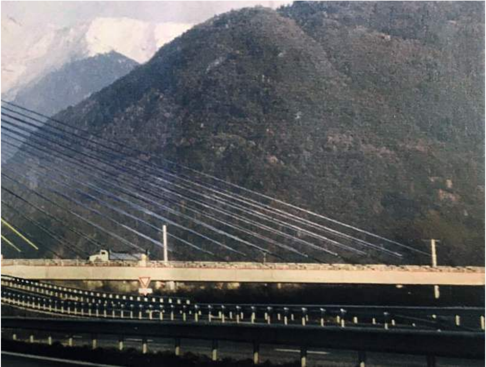
Rendue nécessaire par l'étroitesse du terrain disponible pour ancrer les haubans, l'inclinaison du mât accentue l'effet de porte d'entrée dans le territoire des Jeux olympiques d'Albertville de 1992.
