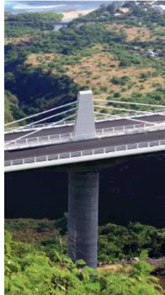
Les séismes, les cyclones et la violence des précipitations imposent une solution technique originale : la précontrainte extradossée.
