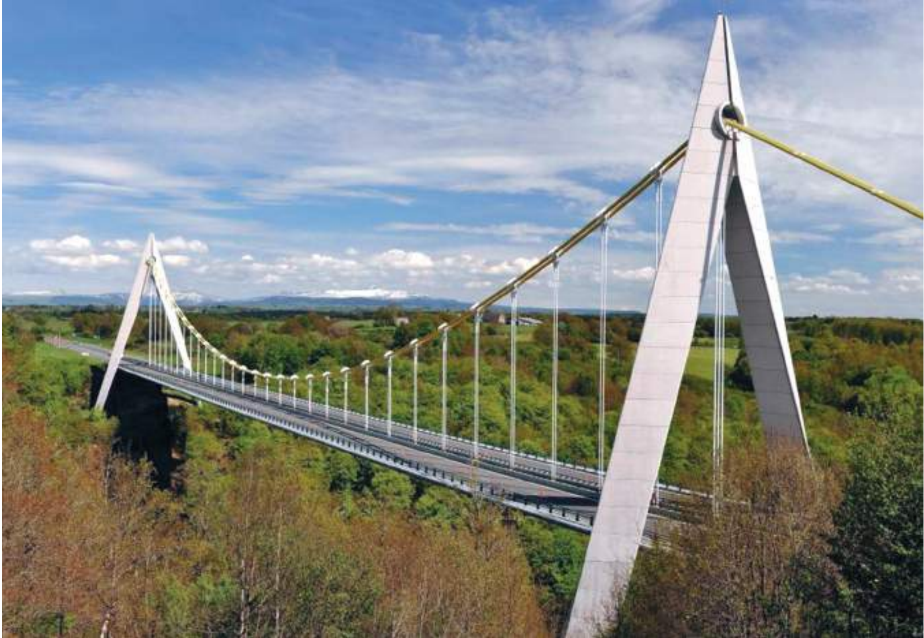
L'effet de signal recherché par le concessionnaire de l'autoroute est pleinement atteint grâce au choix de la solution à suspension centrale et à la forme donnée aux pylônes.
