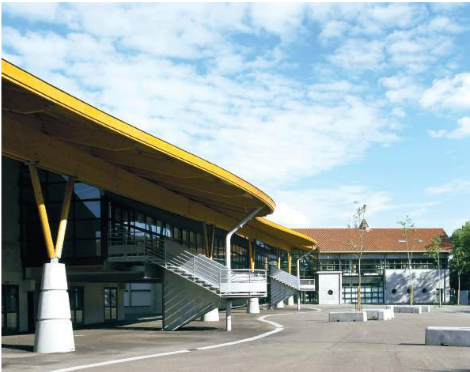
Le débord de toiture abrite une circulation extérieure, les escaliers d'accès à l'étage et forme préau.
