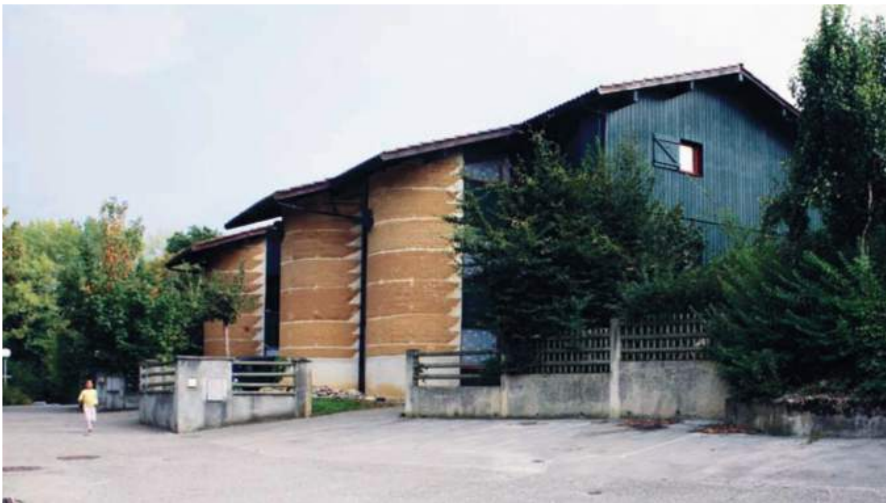
Îlot B, façade nord : le pisé est protégé par le débord des toitures et, en pignon, par un bardage bois sur isolation extérieure.
