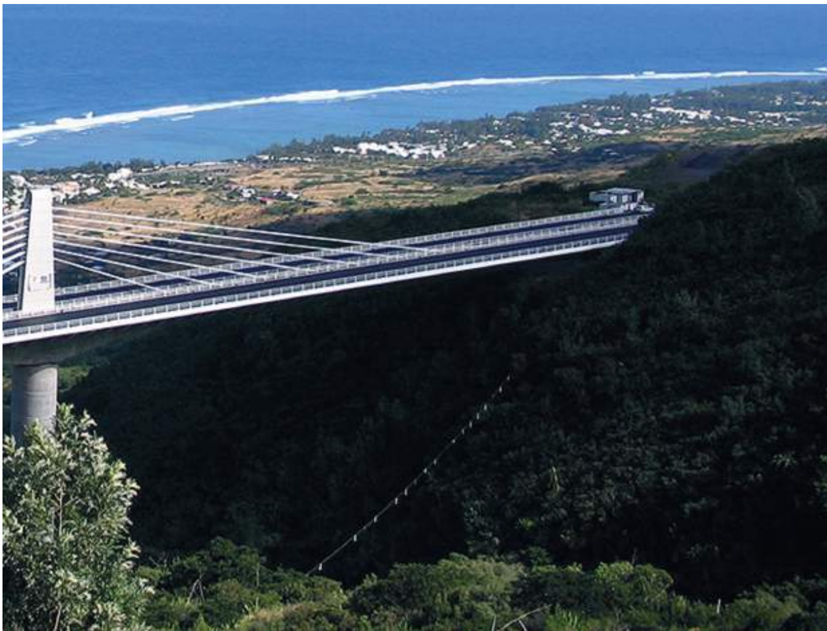
Vue de terre et de la mer, le viaduc présente un profil évoquant une goélette.
