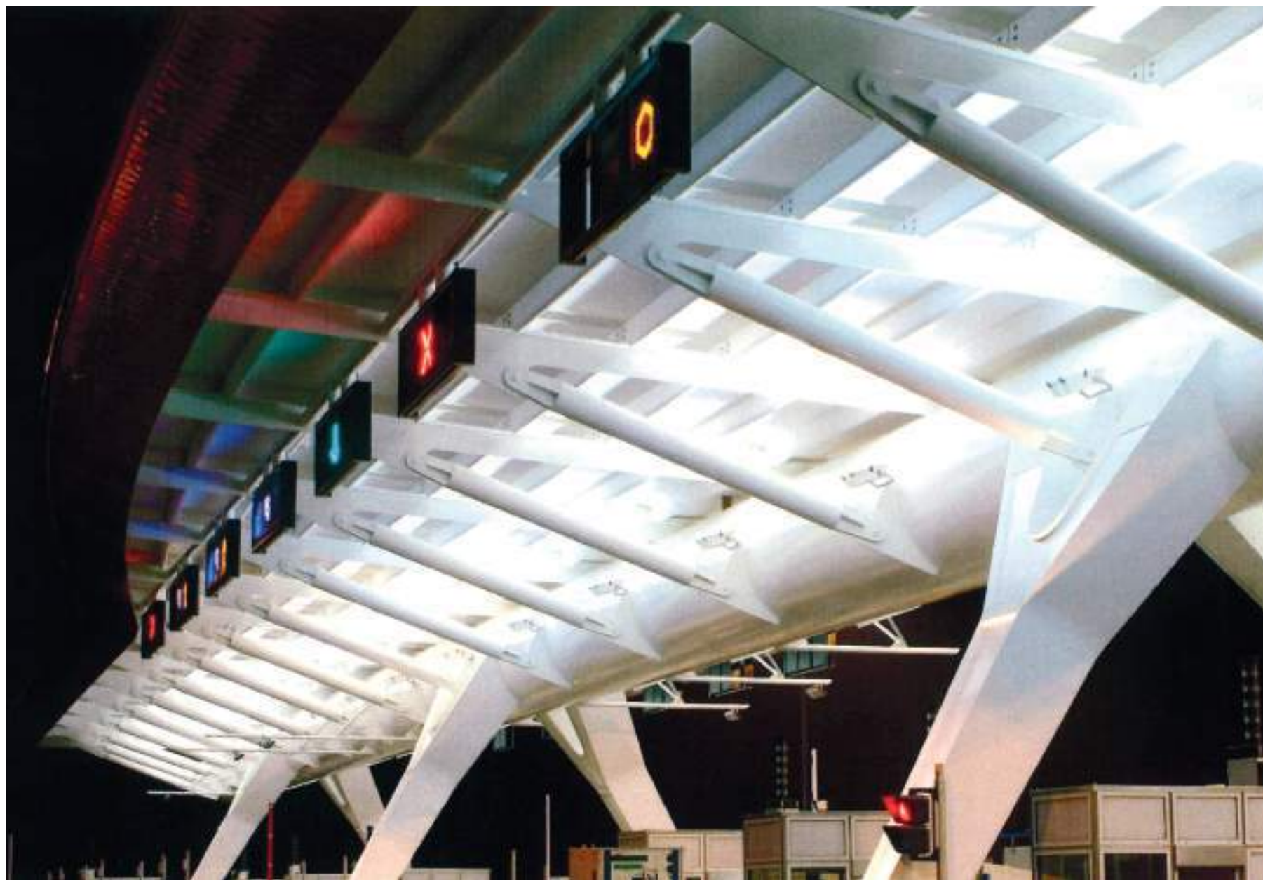
Pour des raisons sismiques, la longue structure métallique, bien que reposant sur de puissants piliers, prend appui sur le bâtiment des bureaux d'exploitation du péage.
