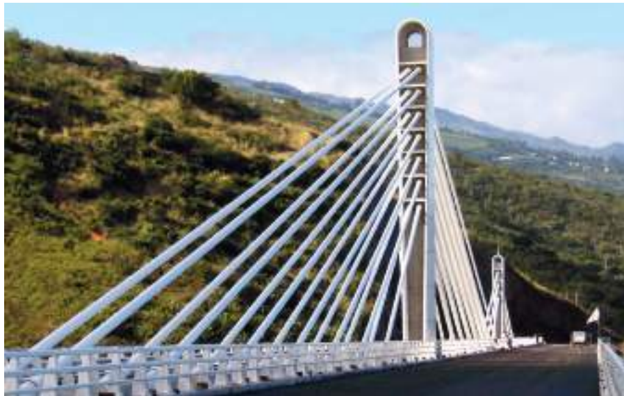
Les séismes, les cyclones et la violence des précipitations imposent une solution technique originale : la précontrainte extradossée.
