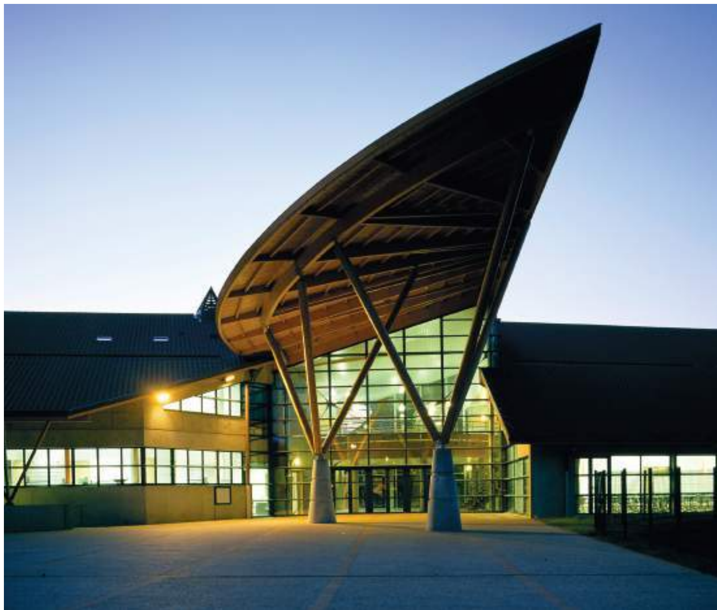
L'auvent surdimensionné constitue un signal avenant mais aussi un espace protecteur pour les collégiens soumis à un temps d'attente entre ramassage scolaire et ouverture de l'établissement.
