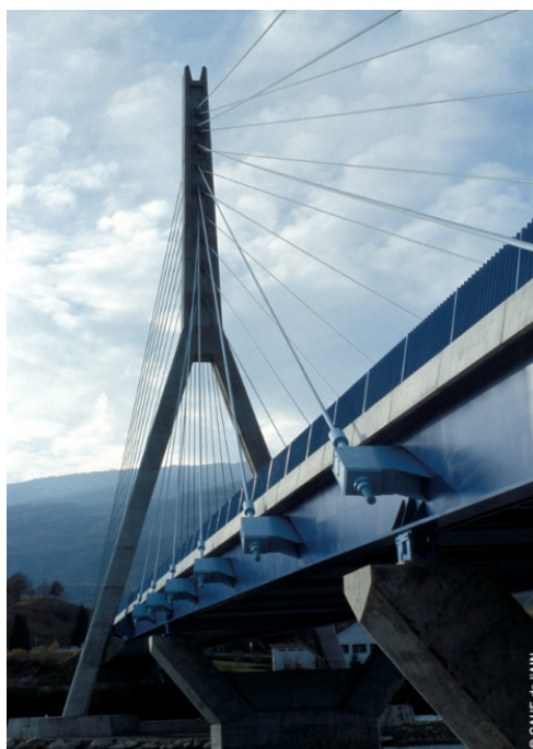
Pont de Seyssel
