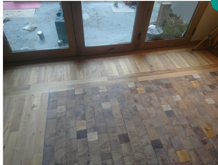
Bois de récupération mis en forme pour réaliser ce parquet en « bois debout ». La valeur du produit est transférée vers la main d'œuvre.
