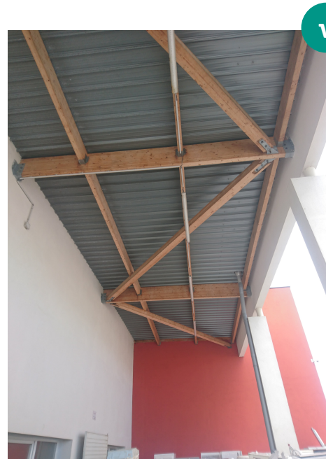
Poutre de lamellé-collé réemployée ayant subi des essais de résistance mécanique avant sa 2 ème vie en œuvre.
