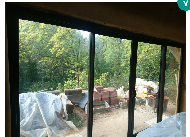
Baie vitrée de rebut a été réparée au niveau de sa serrurerie pour son réemploi. La valeur du produit est transférée vers la main d'œuvre.
