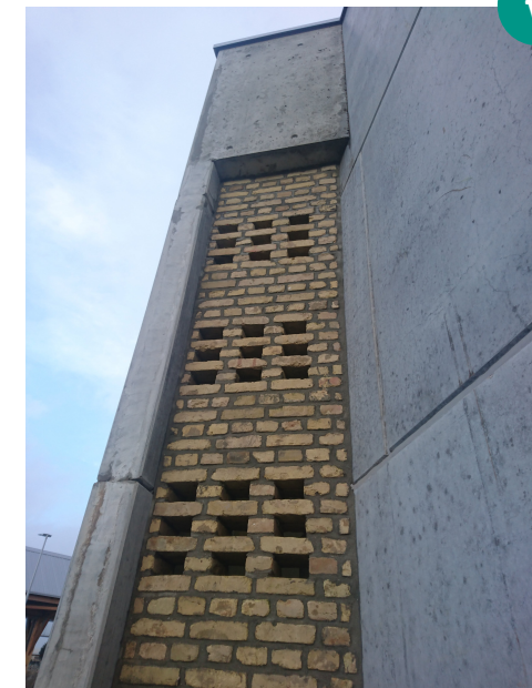
Réemploi de briques réussi grâce à une organisation et planification logistique des différents services concernés.
