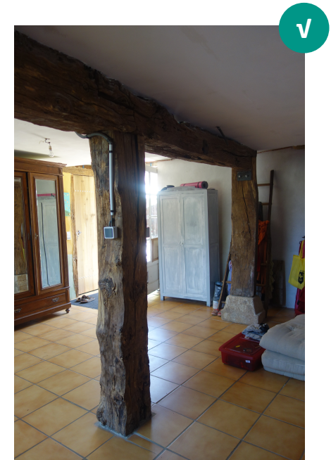
Poutres de bois massif de réemploi surdimensionnées pour soutenir le plancher intermédiaire .
