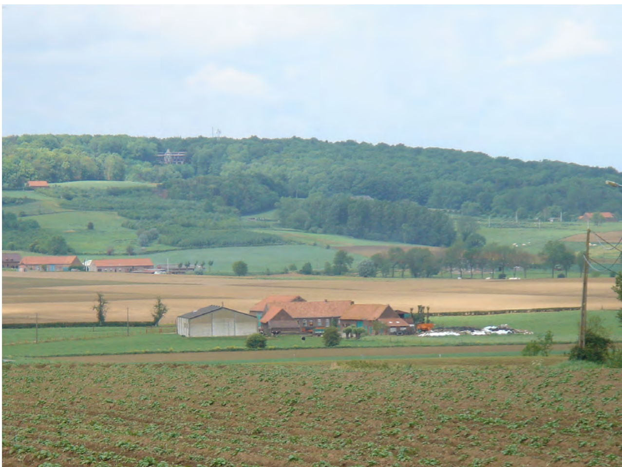
Vrachtwagens kunnen op deze hoeve onvoldoende bij de gebouwen komen: de functionele draagkracht van het hoeve-ontwerp is niet in overeenstemming met de hedendaagse gebruikseisen.
