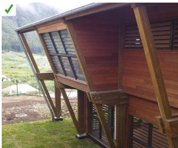
Débords de toits importants limitant l'impact de la pluie sur les bardages en bois. L'inclinaison des façades les moins protégées par les débords de toiture limite le ruissellement de l'eau sur le bardage. ©AQC
