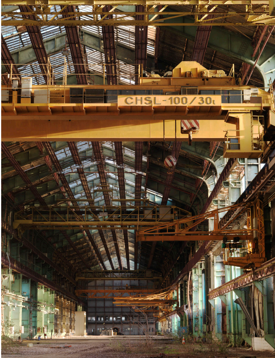
Mantes-la-Ville, usine de pompes Sulzer
