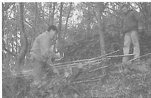
Travaux de canalisation sur le teruil de Ferfay - Association Carreau Vert. (Photo: Philippe DUPUICH)
