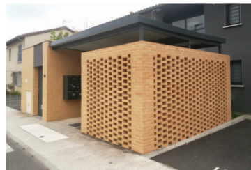
Buzet-sur-Tarn / Locaux poubelles et vélos.
