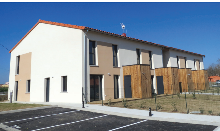
Merville / Habitat groupé - 40 logements en plusieurs unités bâties / Conception : AM PM architectes.
