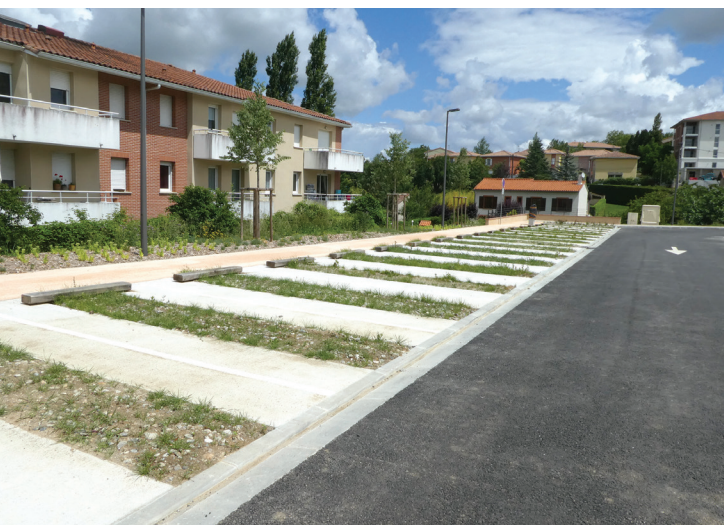
Nailloux / Stationnement béton et mélange terre-pierre.
