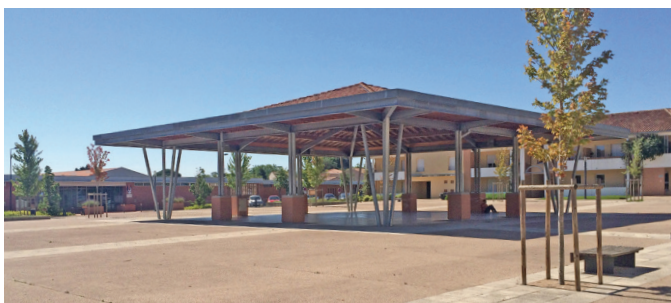
Auzeville / Halle, élément structurant de la place du nouveau quartier du « Pont du bois ».
