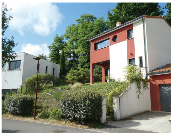
Pechabou / Absence de clôture.
