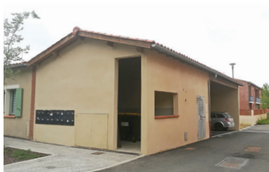
Pechbonnieu / Regroupement d'éléments techniques (dont du stationnement).
