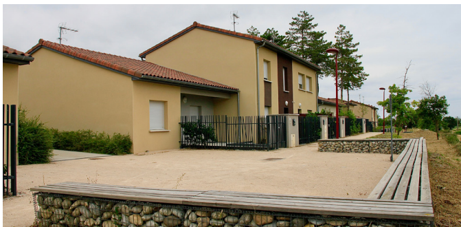
Labastide-Beauvoir / Le cheminement se dilate pour former un petit espace de rencontre.
