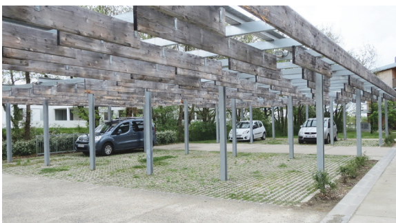
Cornebarrieu / Stationnement soigné, perméable et mutualisé en entrée d'opération.
