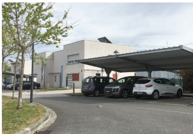
Labarthe-sur-Lèze / Pas de garage mais un abri couvert pouvant être le support de panneaux photovoltaïques.
