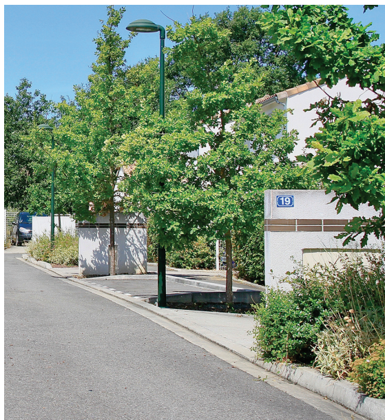
Villaudric / Murets maçonnés supports de coffrets techniques.
