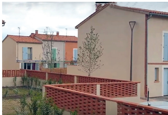
Pechbonnieu / Murets pleins surmontés d'un claustra en briques, en rapport avec l'architecture de l'opération.
