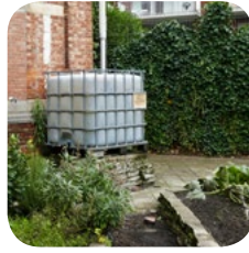
Réservoir de récupération des eaux de pluies
