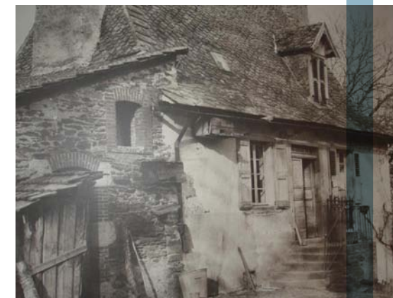
Maison cantalienne réhabilitée
