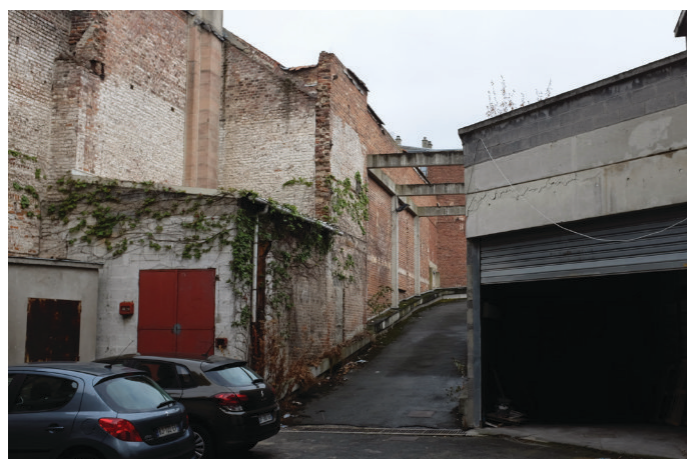
La rampe d'accès au parking de Devianne depuis la rue de Paris
