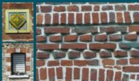
Exemples de mise en œuvre décoratives de maçonneries en brique : faïence, harpage, pose des briques très travaillées.
