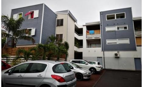
La mise en œuvre de bardages efficaces sur les façades des pièces principales est rare sur les opérations construites avant l'application de la RTAA DOM.
