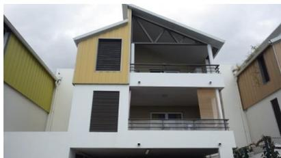
Alternance bardage sur les façades des chambres et aux derniers étages et doublages intérieurs dans les chambres des niveaux inférieurs.
