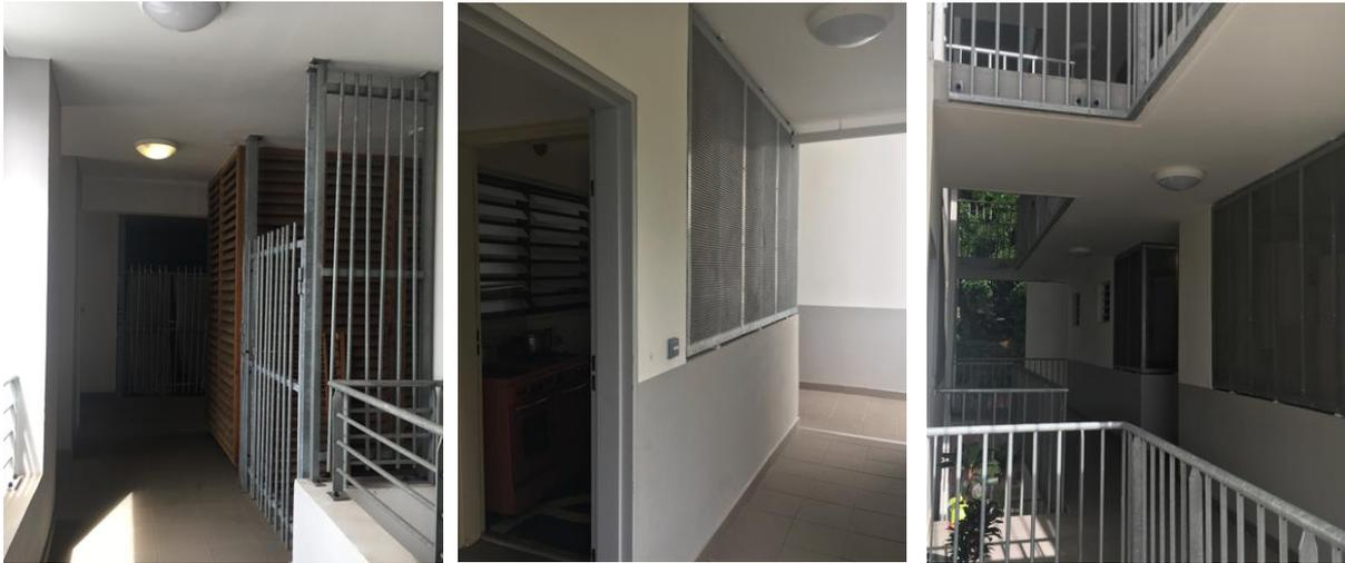
Le sas réduit associé à une partie cellier, masqué en partie par des persiennes ou de la tôle perforée semble répondre au double objectif d'intimité et en même temps de ventilation naturelle.
