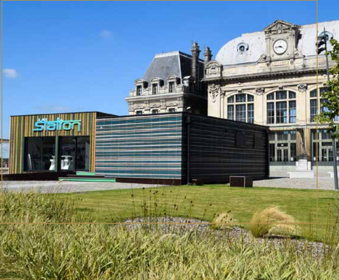
LE PAVILLON PRÉFIGURATEUR. CLICHÉ LA STATION
