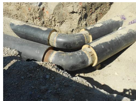
Enfouissement des tuyaux
