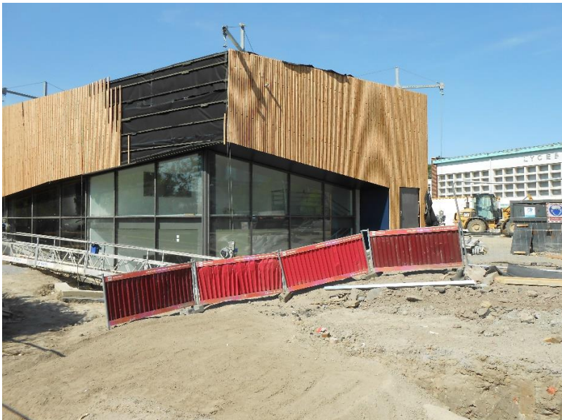
L'échangeur thermique en construction au lycée Pasteur
