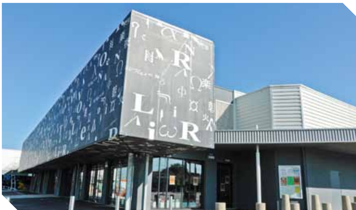
▲ AIZENAY : RÉNOVATION D'UNE PARTIE DE L'ANCIEN CENTRE COMMERCIAL.
