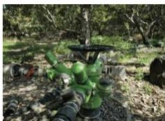
Légende : Une borne d'irrigation raccordée à l'Antenne 0. C'est à ce niveau que les agriculteurs se branchent au réseau ILO.
