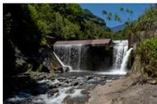
Légende : Le captage de La Rivière du Mât. Au niveau des prises d'eau un barrage guide l'eau vers une grille. C'est par cette grille que l'eau est captée et transférée vers l'ouest de l'île.
