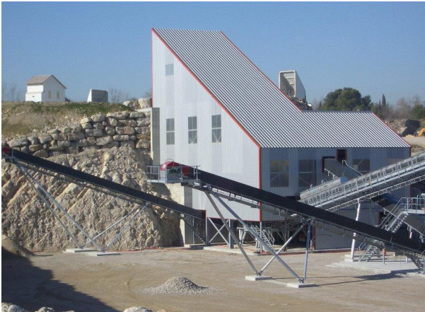
Un bel exemple de traitement architectural d'un concasseur de carrière : positionnement en creux dans un front de taille, accompagnement de la pente par la toiture, sobriété et couleur neutre.
