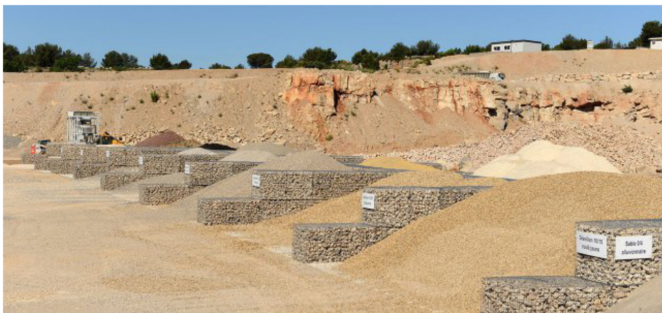
Un exemple intéressant d'organisation des espaces de stockage avec une délimitation par des gabions. Carrière de Saturargues (34)
