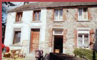
Façade en moellons dérochée dans un ensemble enduit faisant apparaître des matériaux hétéroclites
