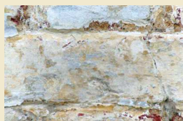
Couches de badigeon de chaux sur un mur de briques
