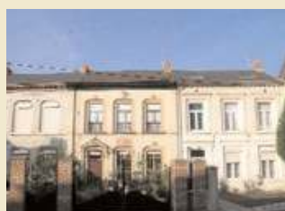
«Image blanche» des alignements de façades enduites ou badigeonnées de l'époque préindustrielle : elle témoigne d'un savoir-faire artisanal local. Les reliefs et moulures sont façonnés dans l'enduit
