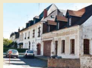
«Image blanche» des alignements de façades enduites ou badigeonnées de l'époque préindustrielle : elle témoigne d'un savoir-faire artisanal local. Les reliefs et moulures sont façonnés dans l'enduit
