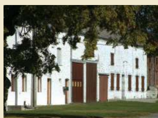
«Image blanche» des alignements de façades enduites ou badigeonnées de l'époque préindustrielle : elle témoigne d'un savoir-faire artisanal local. Les reliefs et moulures sont façonnés dans l'enduit
