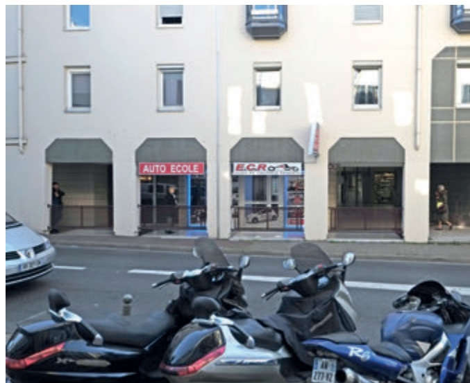
81 Grande Rue : Arcade avec arc plein et galerie
