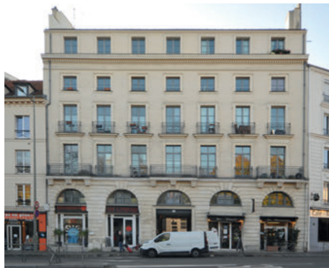
3 Grande Rue : Arcades composant la façade
