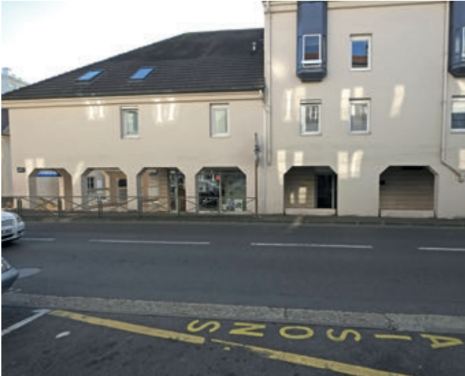
61à 79 Grande Rue : Arcade avec arc surbaissé et galerie
