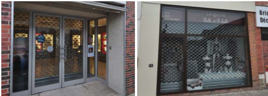
Installer la grille derrière les vitrines est une judicieuse solution.
