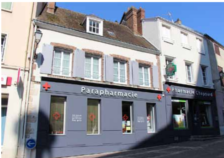
Le commerce s'étend sur deux bâtiments. La devanture s'adapte à chacun des bâtiments (hauteur) et respecte la limite parcellaire tout en offrant une grande unité de traitement.
