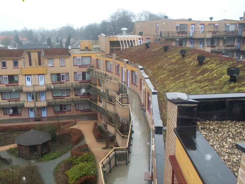
Toiture verte et une mare d'infiltration pour l'eau de pluie.
