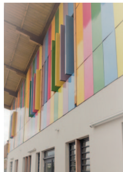
Des panneaux acoustiques orientables protègent les salles de classe des nuisances sonores du plateau sportif et de la route dont l'âme est constituée de résidus et de copeaux de bois compressés issus de l'atelier du menuisier de l'opération.
