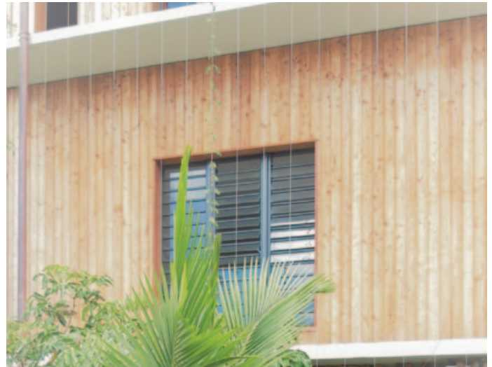
△ Détail d'une façade légère en bois à faible inertie thermique
