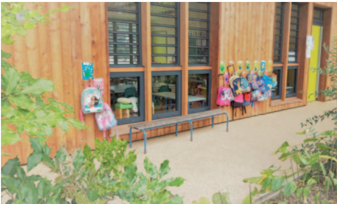
△ De larges baies protégées et des allèges basses procurent un confort visuel appréciable pour les marmailles.
