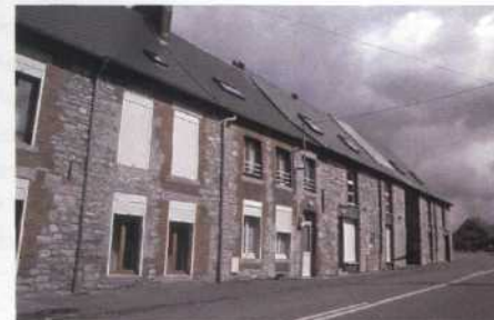
Rénovations du bâti du XVIII e siècle.
