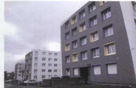
Les immeubles plots des années 1970.
