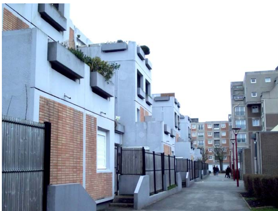
03/ Etat actuel de la rue piétonne (photographie personnelle)
