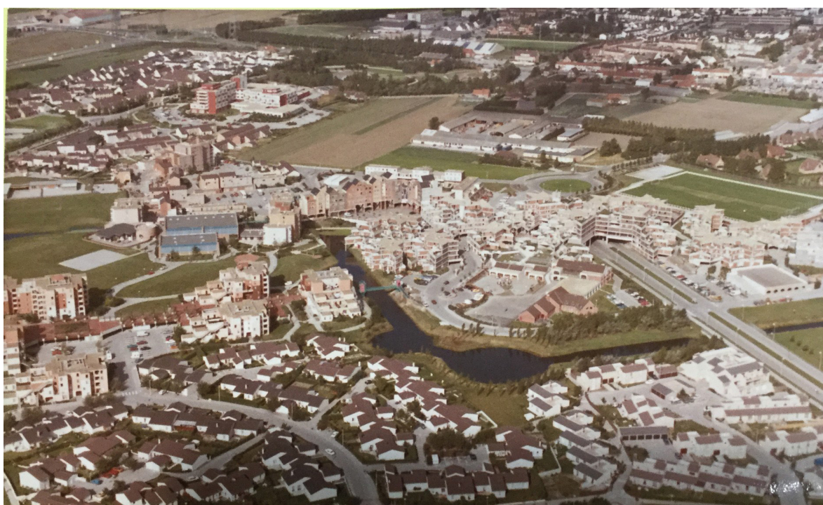
Fig. 6 Le quartier du Courghain à Grande-Synthe : une passerelle piétonne relie l'opération Modèle Innovation M+m (a.r.c. architecture, 1977-1979), à gauche, de l'ensemble de logements de Jean Renaudie (1975-1981) à droite. Photo 1977, archives de Dunkerque, reproduite dans Florence Clipet, fiche Docomomo, séminaire exploratoire ENSAPL, 2017-2018.
