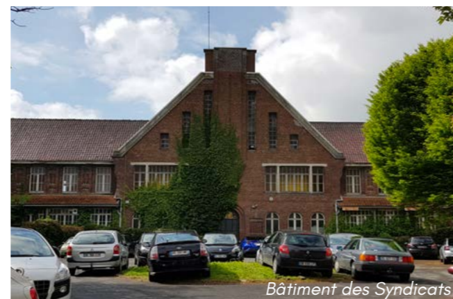
Portail bâtiments des Syndicats
