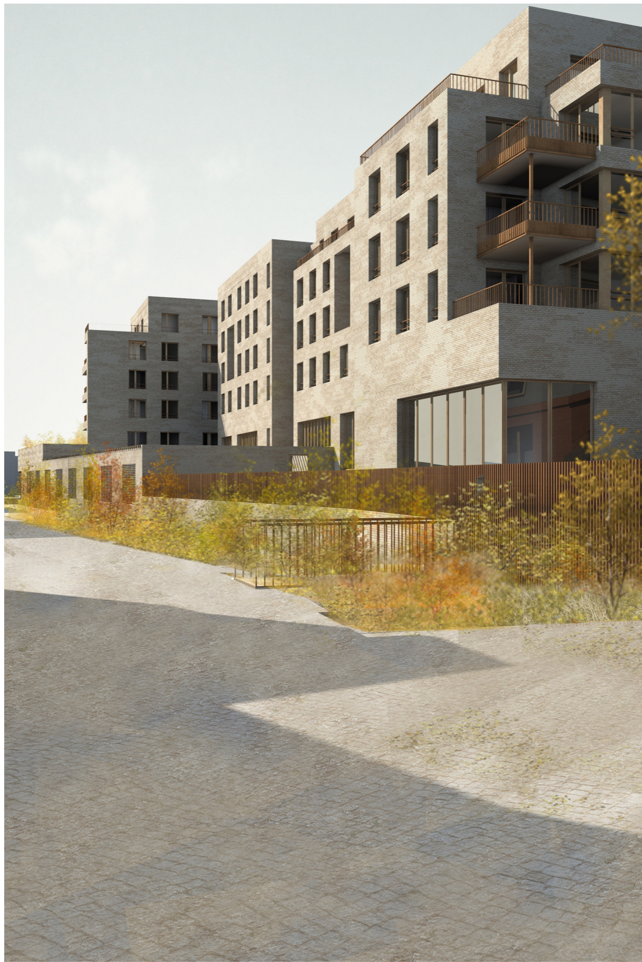
CONSTRUCTION DE 54 LOGEMENTS PLACE DE LA GARE D'EAU LILLE (59)
