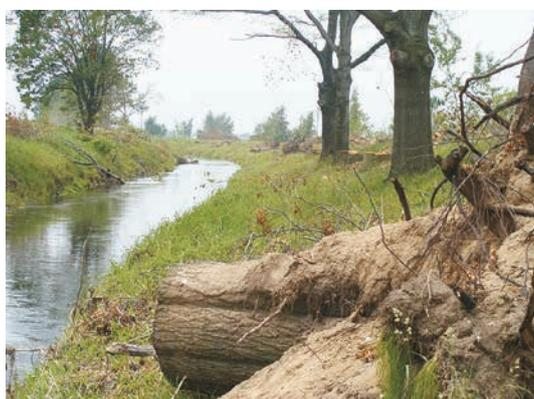
Figure 10.50 **Tronçonnage d'arbres pour s'assurer à nouveau du bon écoulement de l'eau. Souches en arrière-plan, sur la digue de la rive droite**
