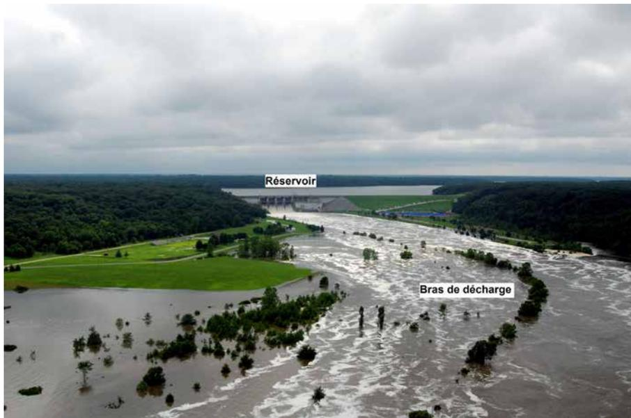
Figure 3.9 **Décharge d'un déversoir depuis un réservoir**
