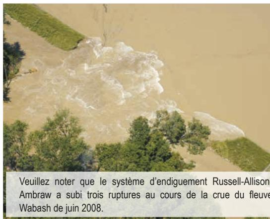
Figure 5.37 **Inspection d'une rupture de digue depuis les airs**
