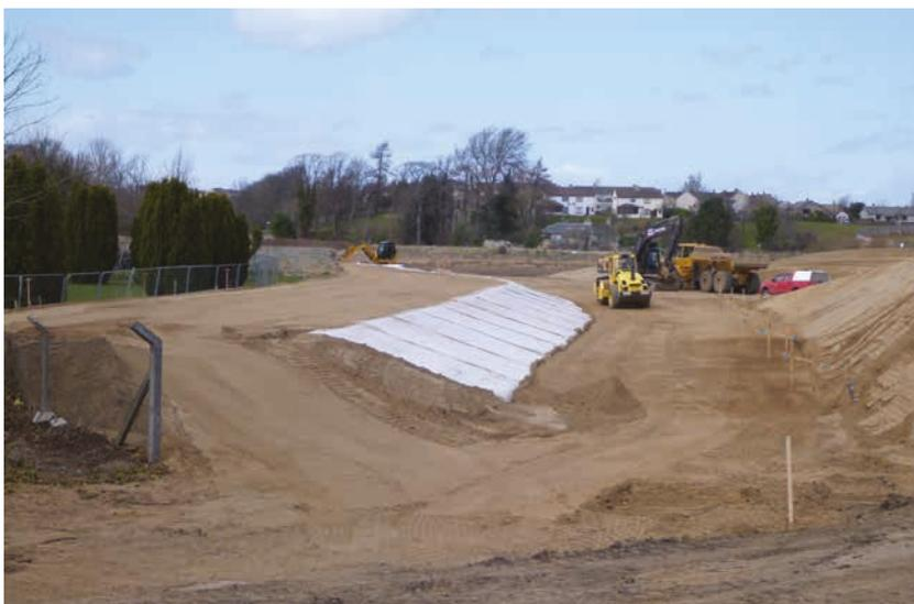
Figure 9.106 **Revêtement de géosynthétique bentonitique incorporé à une digue de sable à Elgin, Écosse**
