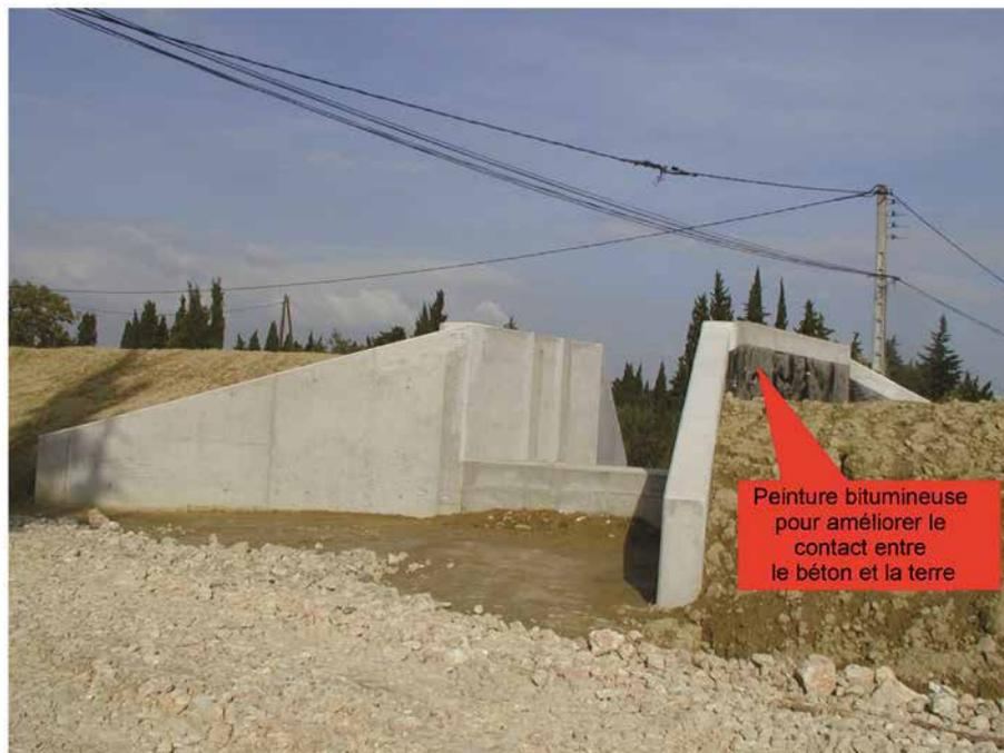
Figure 9.73 Vannes de fermeture terminées, digue d'Aramon, sud de la France (source : Thibaut Mallet)
