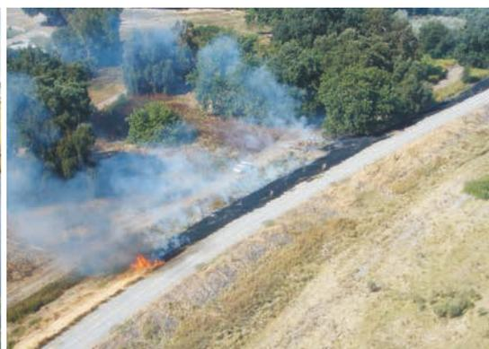
Figure 4.21 **Brûlage dirigé sur le talus d'une digue en Californie, États-Unis**
