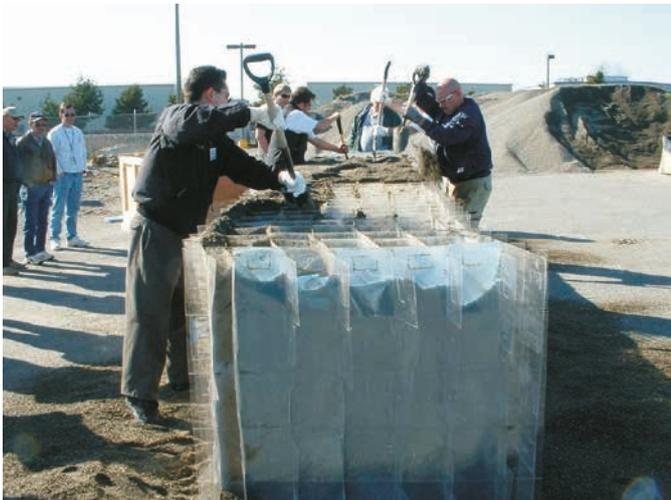
Figure 6.47 **Installation sur le terrain des alvéoles en plastique**
