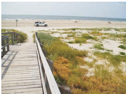
Figure 10.46 **Section de digue entièrement surélevée et végétalisée**
