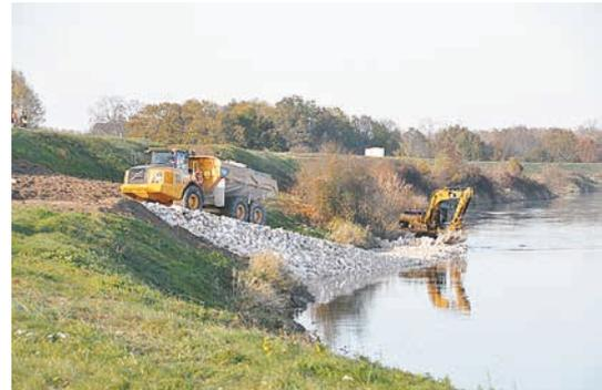
Figure 4.53 Mise en place d'un enrochement pour le renforcement de la base de la digue
