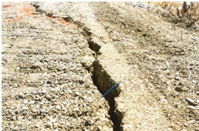
Figure 9.78 **Fracture principale d'un glissement sur la crête d'une digue**
