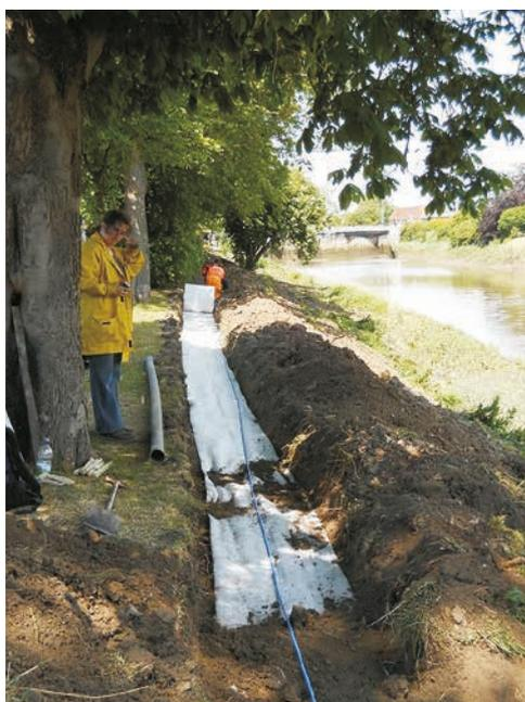
Figure 6.4 **Câble de fibre optique en géotextile posé au sein d'une digue pour mesurer les déformations du terrain sur un site pilote**
