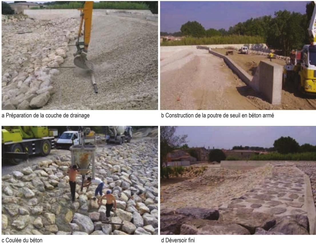
Figure 9.121 **Construction d'un déversoir en enrochement bétonné** (Degoutte *et al.*, 2012)
