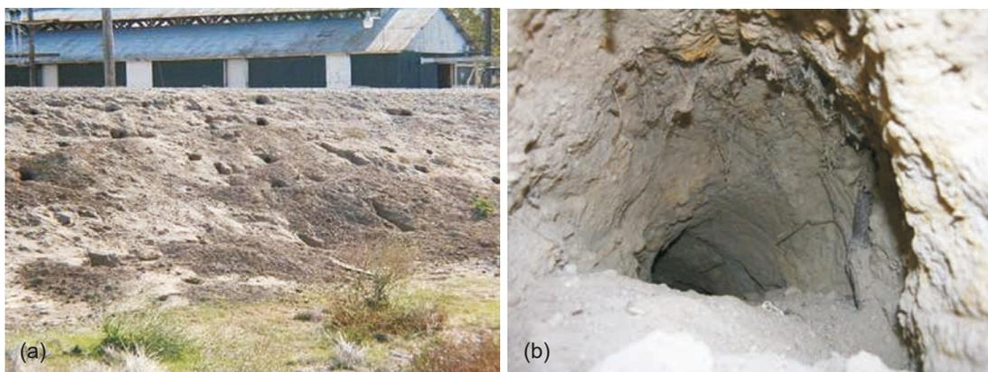
Figure 4.30 **Cavités provoquées par des animaux fouisseurs, (a) plus de cinq trous par section de dix mètres de digue, et (b) un trou isolé supérieur à 15 centimètres de diamètre**
