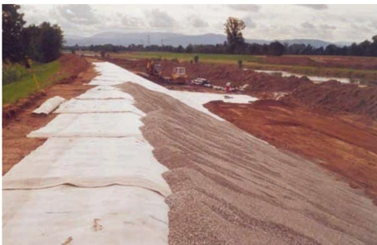
Figure 9.84 **Couverture de revêtements d'argile géosynthétique avec des graviers disponibles localement pour repousser les animaux fouisseurs**
