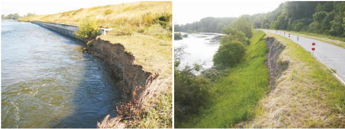
Figure 3.159 **Érosion par les courants d'une rivière et instabilité due au sous-cavage de pied**
