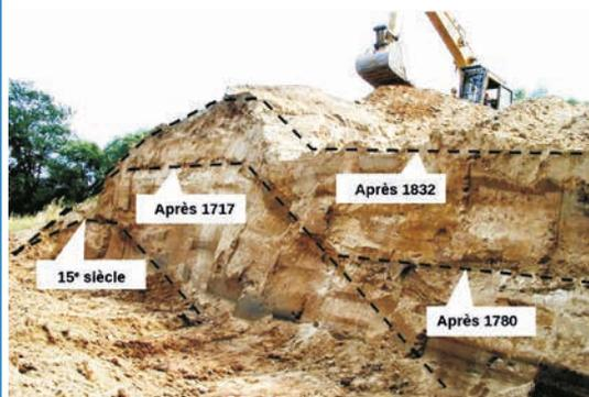
Figure 3.90 **Ancienne section en travers de la digue au km 3**
