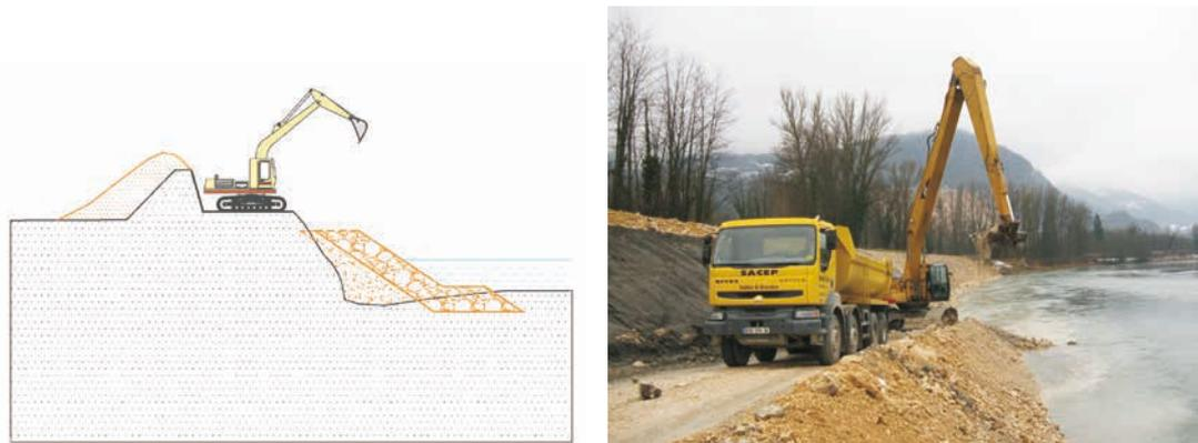
Figure 10.58 Camion apportant les enrochements devant être utilisées par la pelle mécanique
