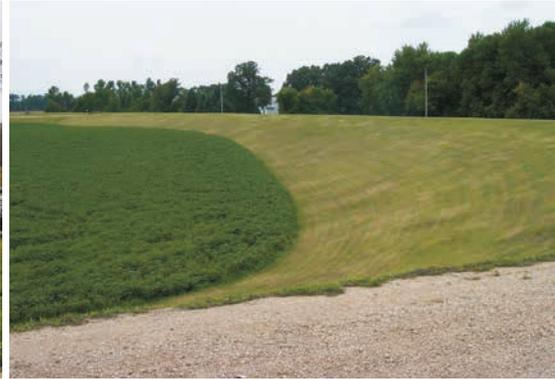
Figure 4.62 **Digue se raccordant au terrain naturel surélevé**
