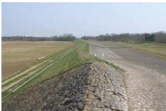
Figure 9.131 **Le seuil de Jargeau, long de 715 mètres et haut de 1,5 mètre, et son merlon fusible enherbé**
