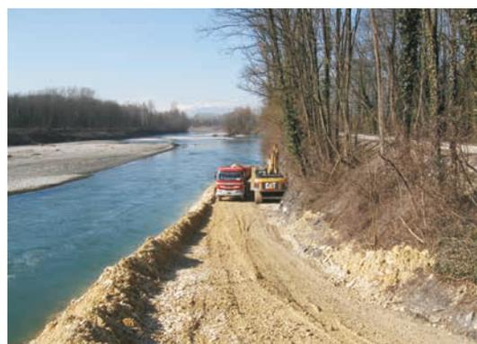
Figure 10.36 **Camion déversant les pierres de protection (a), et pelle mécanique mettant en place les pierres de protection (b)**
