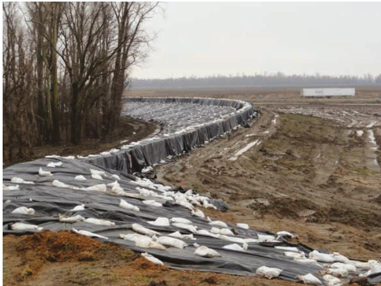
Figure 9.31 **Membrane de polyéthylène disposée sur la digue nouvellement construite pour sa protection temporaire contre l'érosion**
