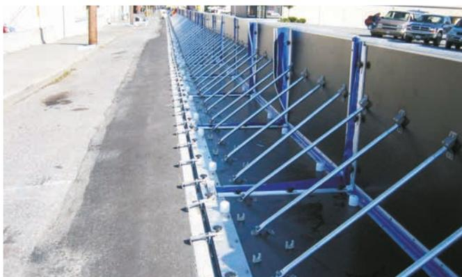
Figure 6.49 Installation du système AquaFence
