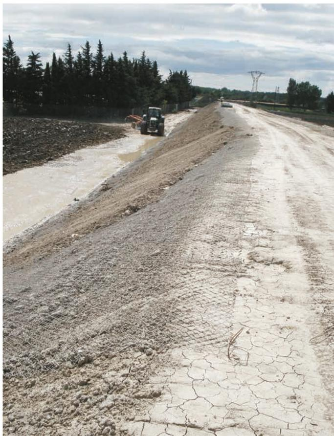
Figure 4.33 Pose d'un grillage en métal à la surface d'une digue
