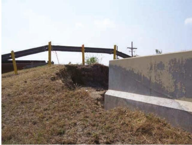
La pratique standard, basée sur le retour d'expérience de l'ouragan Katrina, consiste à utiliser un revêtement en béton pour toutes les transitions. La protection des pentes doit couvrir l'ensemble de toute la hauteur du remblai lorsque le mur a la même hauteur que celui-ci, et le revêtement béton doit s'étendre sur 30 pieds (9 mètres) depuis l'extrémité du mur rigide. Un renforcement approprié doit concerner toute la longueur du mur où des débordements peuvent se produire.
