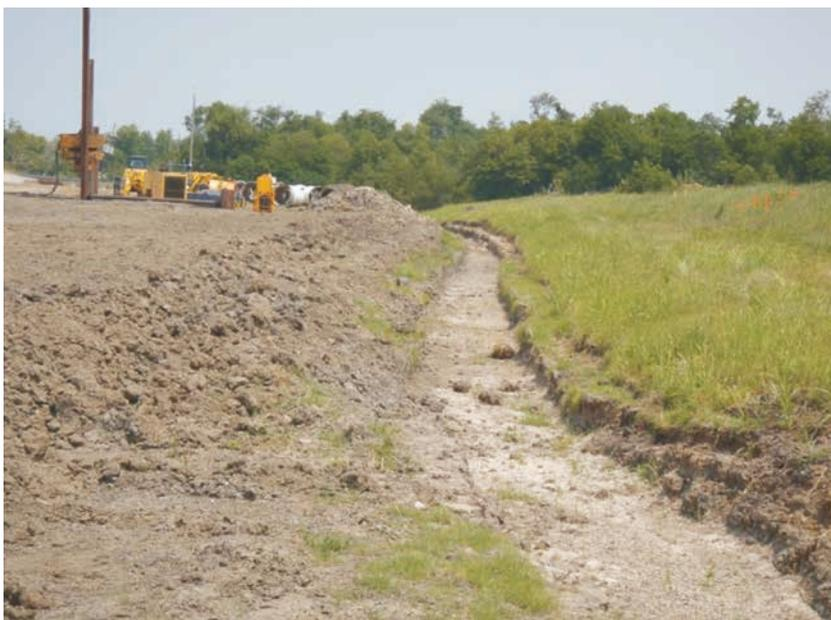
Figure 10.11 **Tranchée de drainage temporaire creusée pour assurer un bon drainage au cours de la construction**
