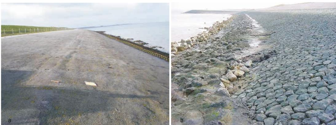
Figure 6.29 **Exemple de digue avec de l'asphalte (a) et un revêtement de pierres (b)**
