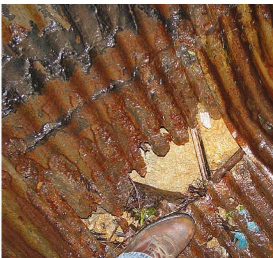
Figure 5.38 **Perte de section complète au fond d'une conduite en tôle ondulée**
