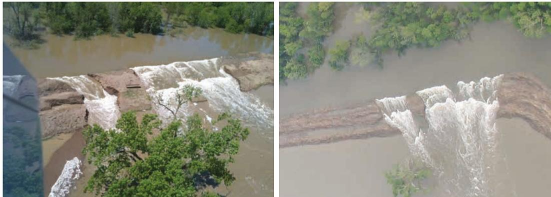
a Vue en plongée montrant le franchissement de la section de digue sacrificielle
