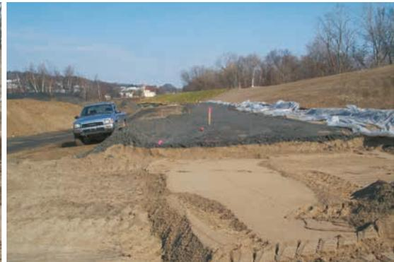
Figure 10.21 **Épandage de matériaux d'emprunt pour déterminer la bonne épaisseur de chaque couche d'épandage avant compactage. Des piquets en bois sont employés pour contrôler l'épaisseur de chacune des couches**
