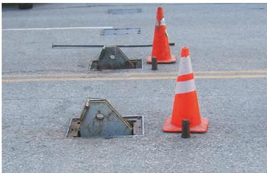
Figure 4.54 Emplacements de fixation dans de l'acier scellé
