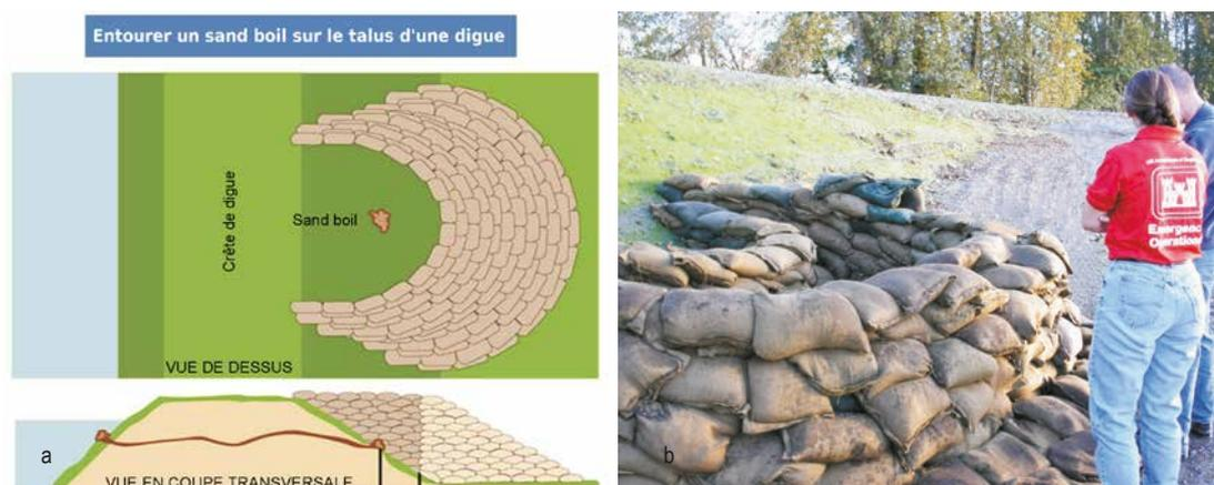
Figure 6.39 **Schéma de confinement d'une résurgence sur un talus de digue (a) et exemple de mise en œuvre (b)**
