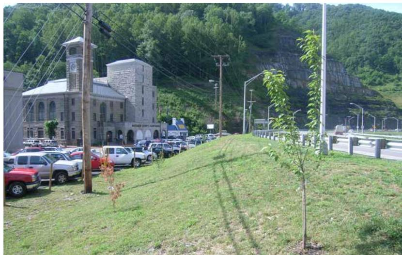
Figure 3.17 **Remblai autoroutier servant de ligne de défense**
