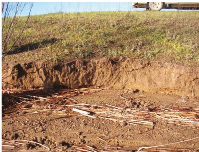
Figure 9.56 **Rupture du talus côté eau après une baisse rapide du niveau d'eau, digue du fleuve Sacramento, Californie**
