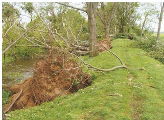
Figure 10.49 **Profil de digue réduit (ainsi que stabilité réduite) en raison d'arbres déracinés**
