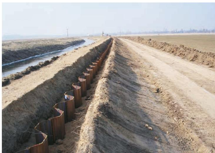
Figure 10.56 Une portion de digue en palplanches de 6 250 m de long. Les extrémités des palplanches et des parois en sol-ciment, sont en dessous du niveau final de crête de la digue, de façon à ce qu'ils ne soient pas visibles après l'achèvement des travaux (source des photographies : E. Bieltz, Autorités des barrages de Saxe, Pirna, Allemagne)
