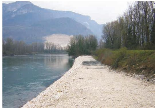
Figure 10.38 Talus achevé mis en place par la pelle mécanique
