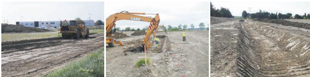
Figure 10.29 **Préparation du site entre des parcelles agricoles (a), creusement de la tranchée d'ancrage (b), mise en place d'un drainage localisé (c)**
