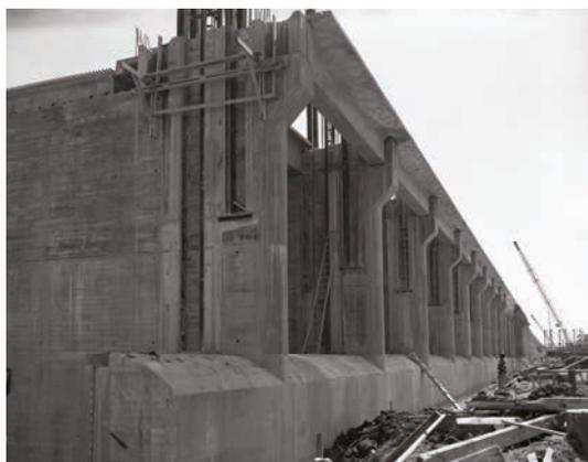
Figure 9.143 **Construction de l'ouvrage de contrôle de Morganza, Mississippi**
