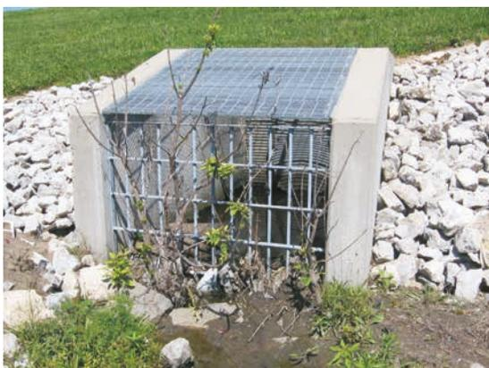
Figure 3.137 **Écran en terminaison amont d'une conduite**
