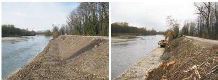
Figure 10.39 Pelle mécanique travaillant sur la risberme
