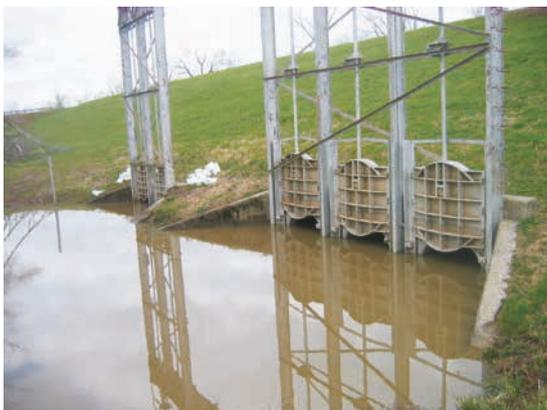
Figure 3.119 **Porte coulissante montée sur un mur de tête**
