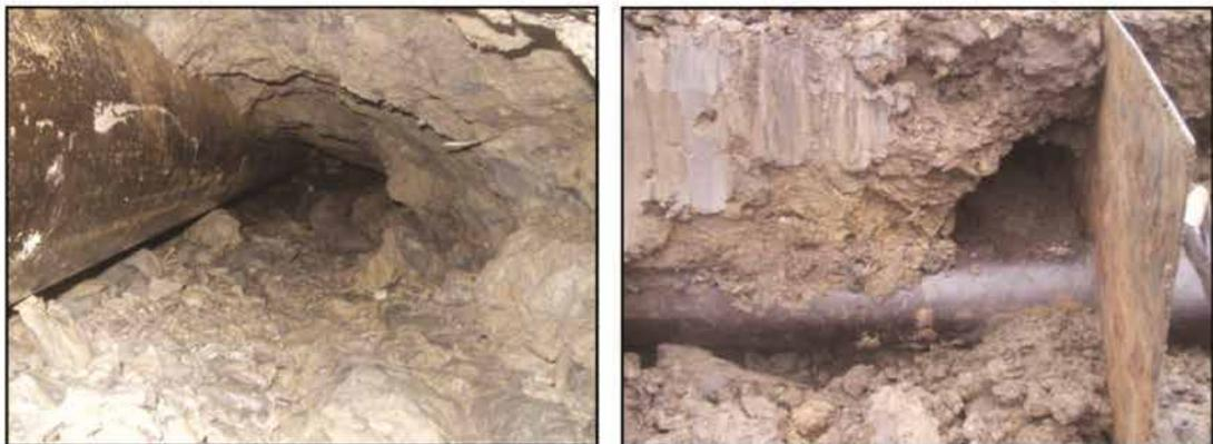
Un vide s'est formé autour de la conduite, dû à un écoulement d'eau à travers la fracture hydraulique.
