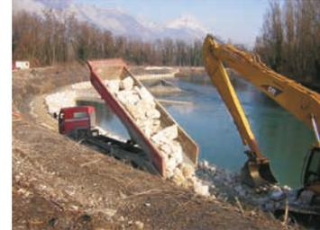
Figure 10.61 **Le camion utilise la risberme pour apporter à la pelle mécanique les enrochements devant être mis en place**
