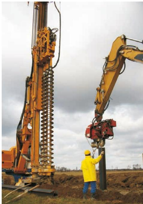
Figure 10.54 La technique de mélange en place (MEP) a été utilisée sur un tronçon de 6 950 mètres de long. À gauche : une tarière tricône destinée à creuser le sol et à le mélanger avec le liant hydraulique en suspension. À droite : mise en place de poutrelles en acier dans le mélange encore frais de terre et de ciment
