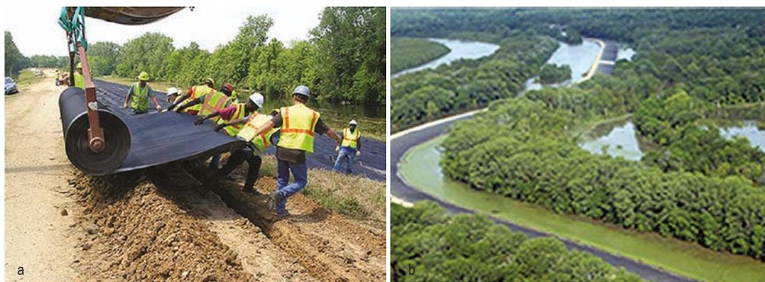
Figure 6.32 **Utilisation de la bâche en plastique pour empêcher l'érosion par franchissement/surverse, positionnement de la bâche en plastique sur la digue côté eau (a) et dispositif en place (b)**
