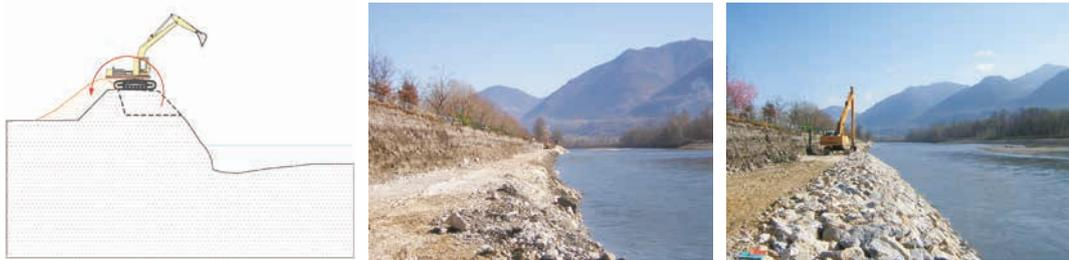
Figure 10.57 Une pelle mécanique façonne la digue, de manière à permettre un accès
