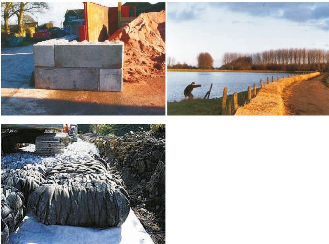
Figure 6.24 **Blocs légers en béton (a), bottes de pailles (b) et balles de pneus (c)**
