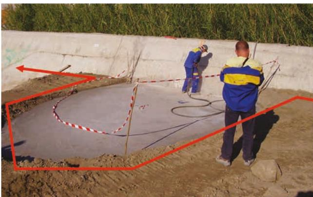
Figure 9.69 **Bouchon de béton installé pour allonger le cheminement des écoulements potentiels**
