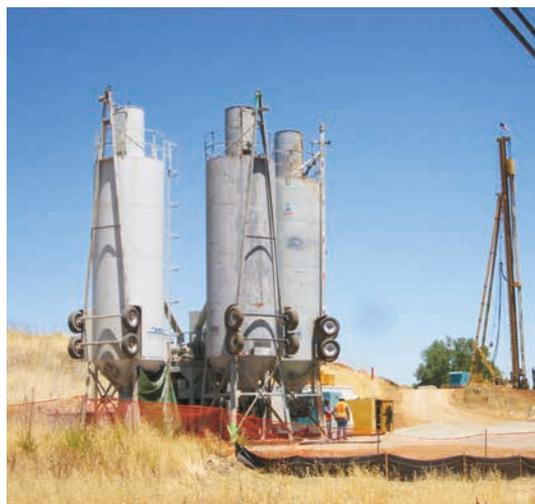
Figure 10.19 **Solution aux infiltrations avec un mélange renforcé de sols à Marysville, en Californie, aux États-Unis**
