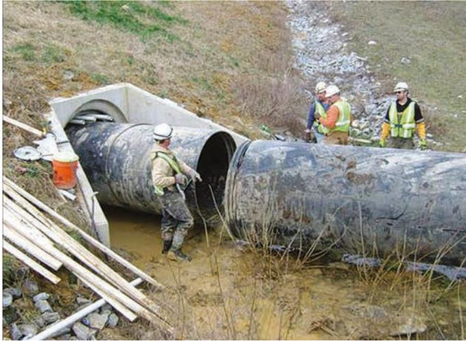
Figure 10.72 **Installation classique d'un tubage par segments, système de digues de New Albany, dans l'Indiana, aux États-Unis**
