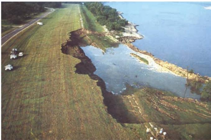
Figure 9.54 **Rupture sur le fleuve Mississippi imputable à la baisse rapide du niveau d'eau**
