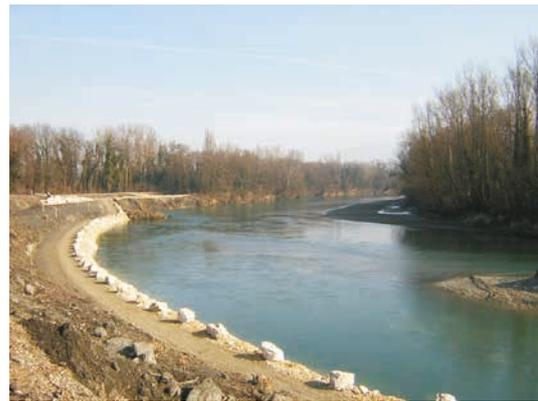
Figure 10.62 **La pelle mécanique façonne la risberme pour lui donner sa forme définitive**
