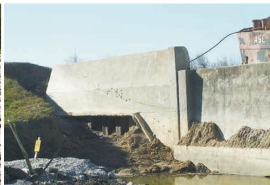
Figure 4.64 **Arrachement du côté terre d'une transition entre la digue et le mur de lutte contre les inondations suite à une surverse**
