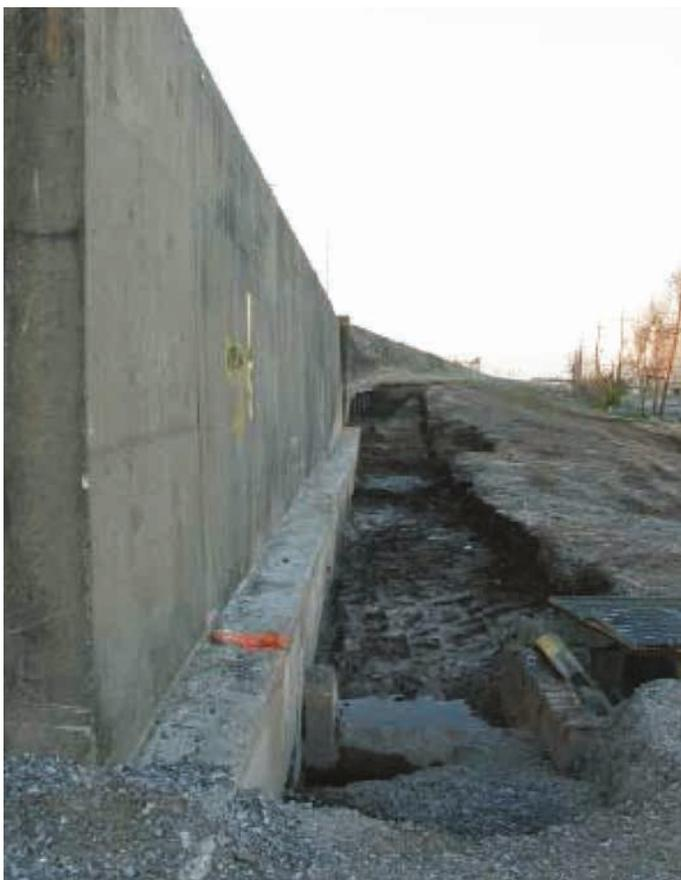
Figure 9.33 Fosse d'affouillement au pied d'un mur « en T » du côté est du canal de navigation d'arrière-port (IHNC) après l'ouragan Katrina, Nouvelle-Orléans, États-Unis
