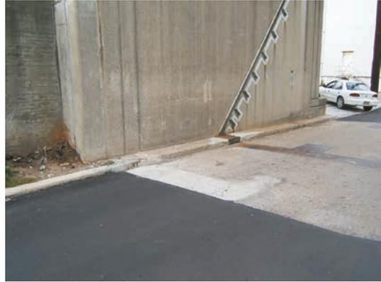
Figure 4.60 **Seuil en béton restauré et nouveau revêtement en asphalté au-dessus du seuil abritant la conduite de gaz.**
