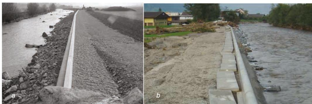
Figure 9.141 **Seuil-fusible sur la rive droite de l'Aa Engelberger (a) avant et (b) après la crue** (source : Degoutte *et al.*, 2012)
