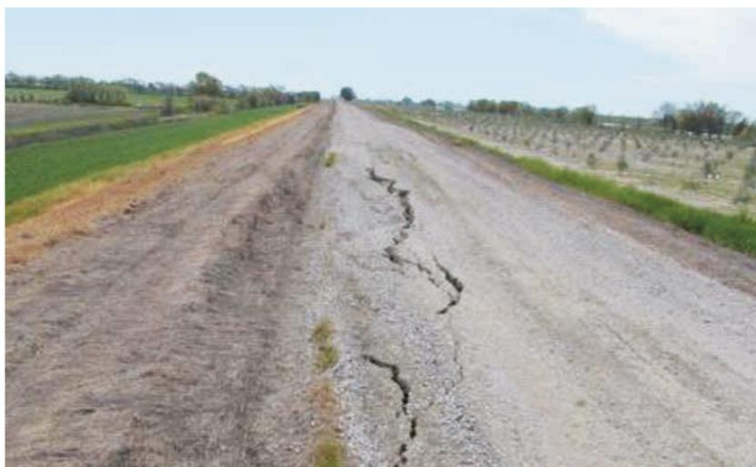
Figure 4.48 Fissures apparues le long de la crête de digue
