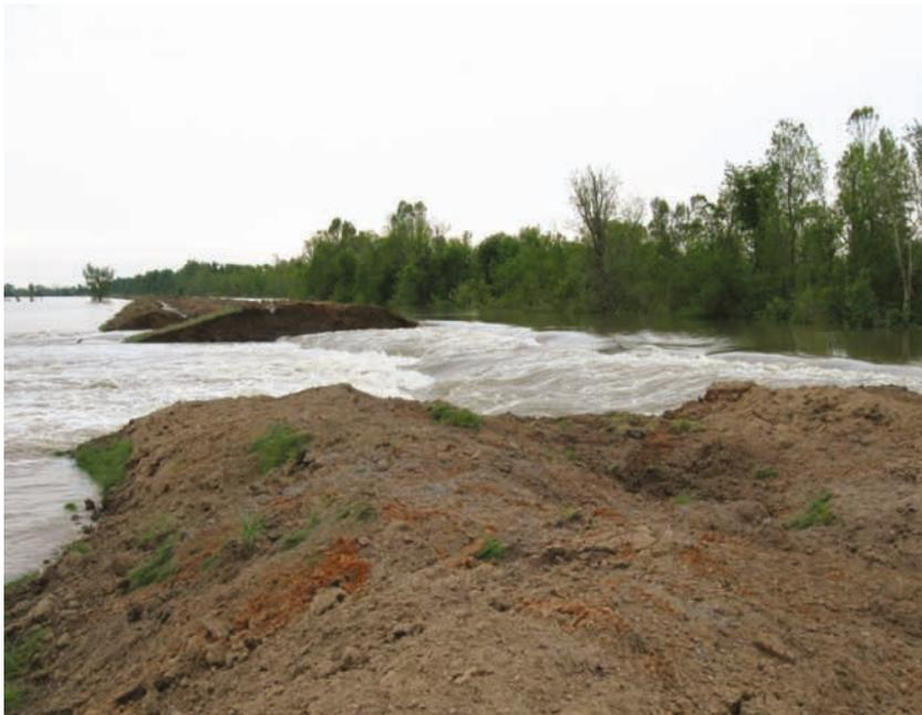
Figure 9.130 **Seuil-fusible en terre après activation au moyen d'explosifs, canal de dérivation de Birds point-New Madrid sur le Mississippi**
