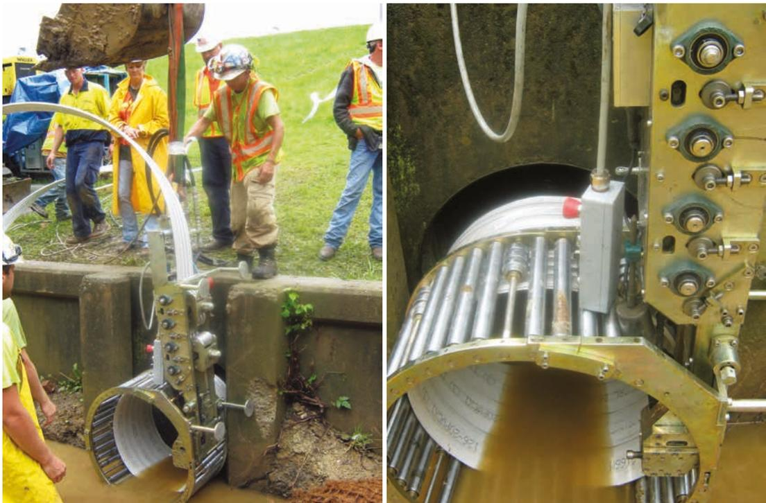
Figure 10.73 **Installation classique d'un tubage en spirale, système de digue de Jeffersonville/Clarksville, dans l'Indiana, aux États-Unis**
