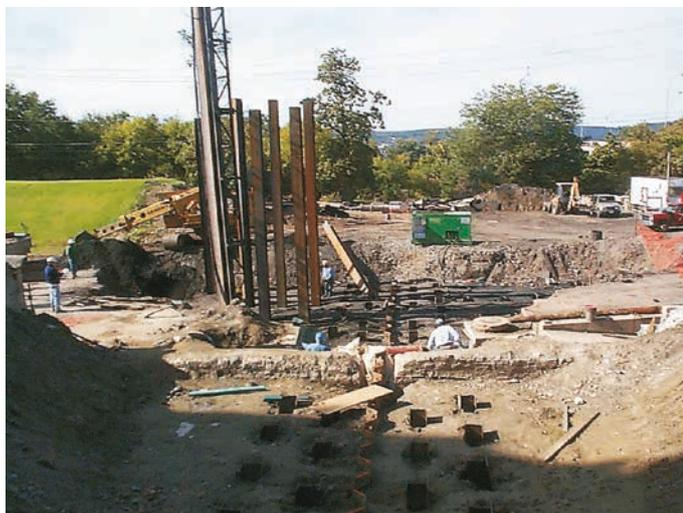
Figure 10.67 **Profilés en H destinés à constituer les fondations d'un ouvrage de fermeture**
