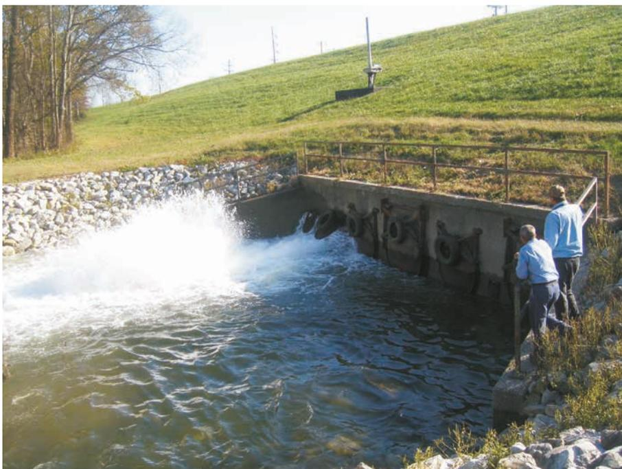
Figure 3.115 Relargage d'eau de conduite de décharge en provenance d'une station de pompage
