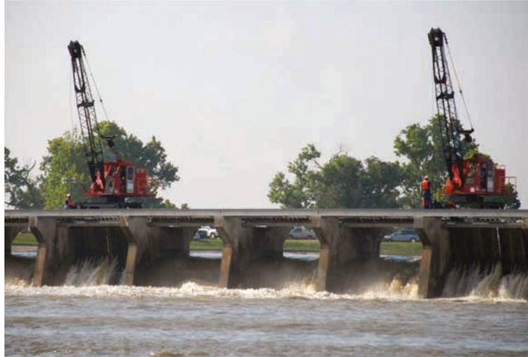
Figure 9.134 **Grues soulevant les aiguilles pour ouvrir le déversoir, ouvrage de régulation de Bonnet Carré**
