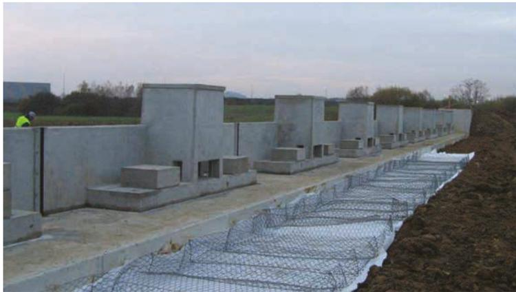
Le principe de seuil basculant a été modifié par l'inclusion d'une tour en béton (cf. figure 9.139). Ce design accroît la fiabilité du système en prévenant l'accumulation de débris et le vandalisme. La figure 9.139 montre la construction de gabions pour augmenter la résistance au débit de débordement.
