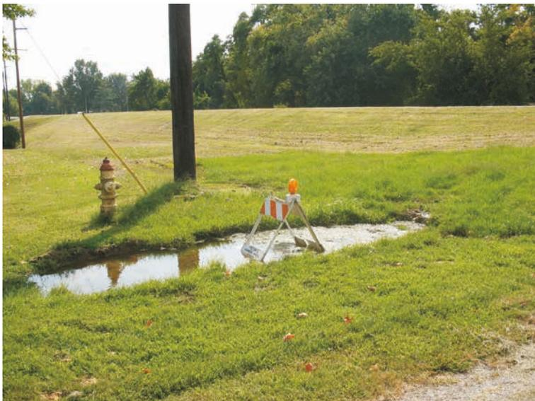
Figure 4.57 **Indice d'une fuite de canalisation d'alimentation en eau – accumulation d'eau au niveau du pied de digue côté zone protégée**
