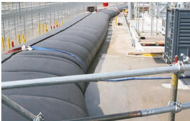
Figure 6.50 **Installation d'un barrage gonflable à l'eau**
