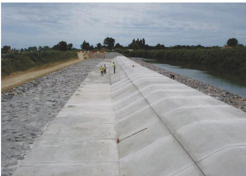
Figure 9.119 **Déversoir en dalles de béton armé, rivière Lez, France**
