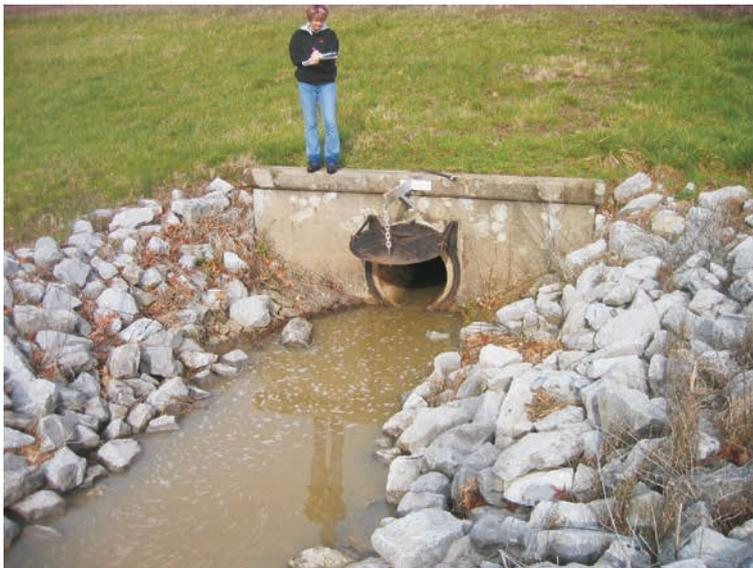
Figure 5.41 **Inspection d'une sortie de galerie**
