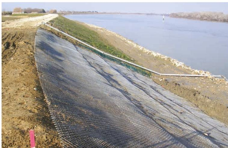
Figure 9.82 **Grillage de protection contre les animaux fouisseurs mis en oeuvre lors de travaux de renforcement de digue à Arles, France**
