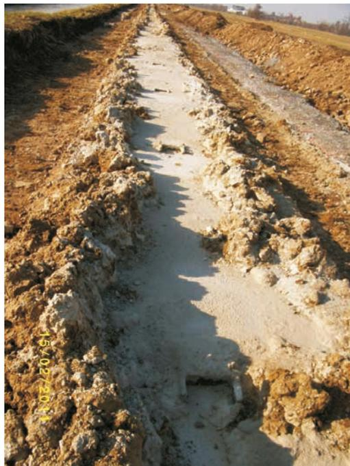
Figure 10.55 Paroi moulée en sol-ciment, après la mise en place des poutrelles de renforcement en acier, et avec un espacement déterminé à partir de calculs de stabilité
