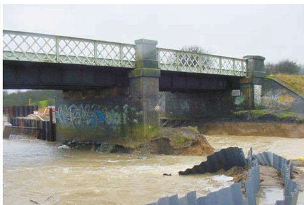
Une inondation au cours d'une intervention sur une digue affecte directement le maître d'ouvrage et le public sur les domaines de la sécurité publique, de la programmation et du financement du projet. Au cours de la construction d'un réservoir de stockage des crues au Royaume-Uni, une crue a inondé le site (cf. figure 10.10). Le maître d'œuvre et le constructeur de la digue ont coordonné leurs efforts pour préserver la sécurité publique au cours de la construction.
