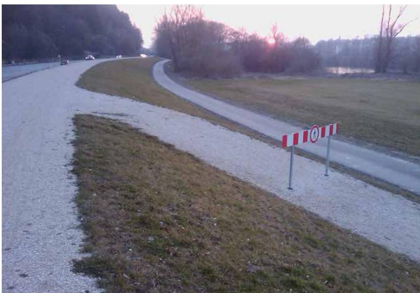
Figure 3.15 **Rampe d'accès dans une digue du Danube près de Regensburg, Allemagne**
