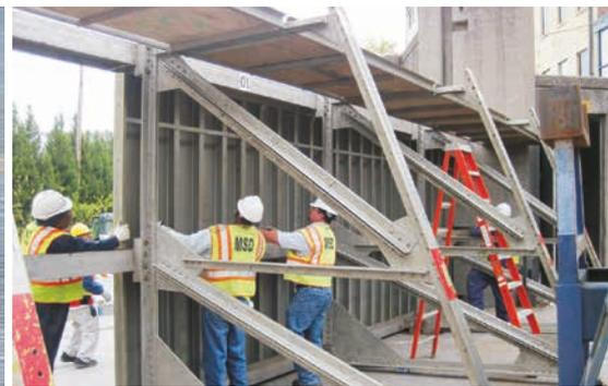
Figure 4.55 Supports de fixation intermédiaires installés en position d'ancrage
