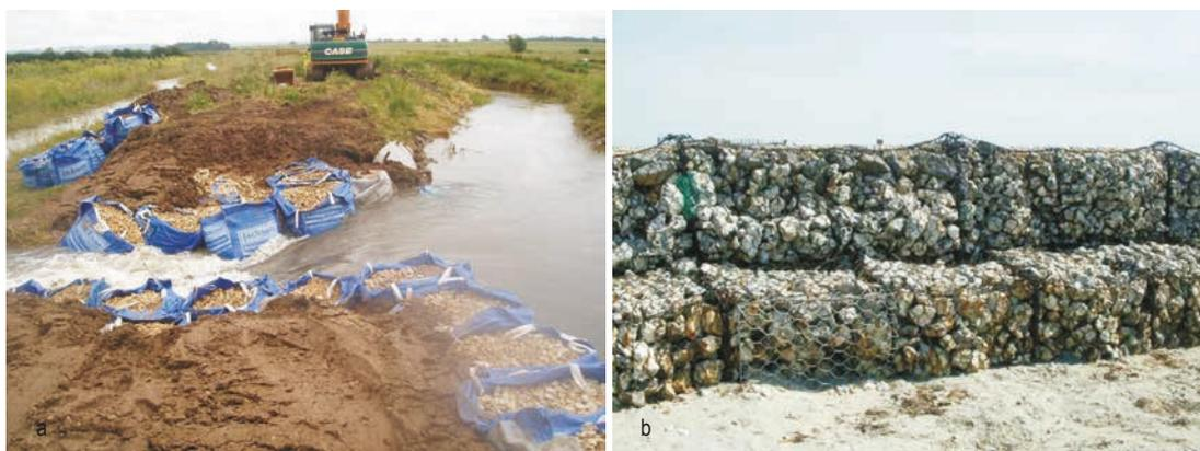
Figure 6.44 **Réponse à l'ouverture d'une brèche, limitation de la croissance de la brèche en utilisant des big bags (a) et des gabions (b)**
