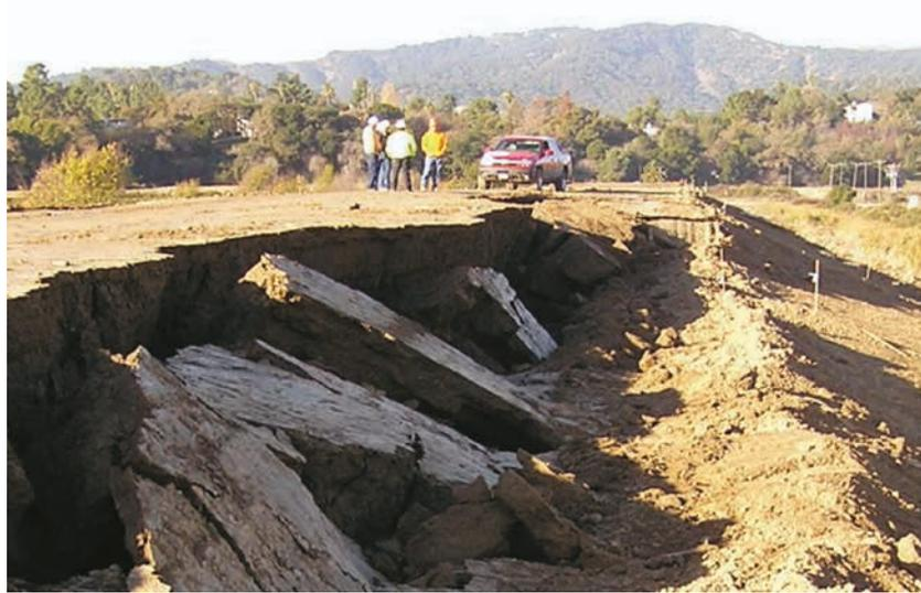
Figure 9.50 **Défaillance d'une digue à la fin de la construction, Californie, États-Unis**
