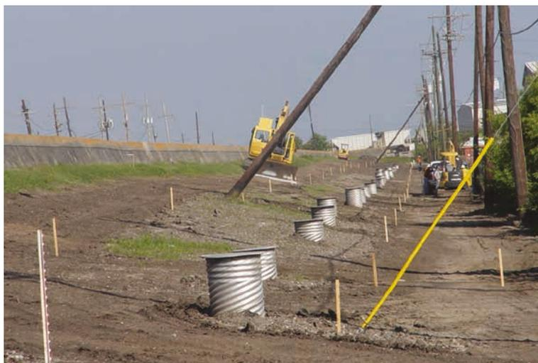
Figure 9.44 **Puits de décompression au niveau du pied côté terre une fois terminés raccordés à un tuyau d'amenée enterré** (orientation nord en direction du lac Pontchartrain)
