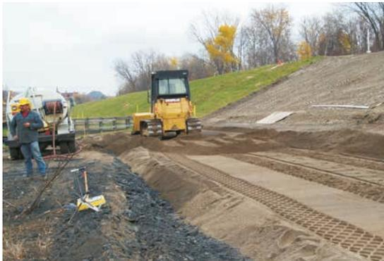
Figure 10.20 **Épandage de matériaux en vrac en une couche uniforme avant compactage**
