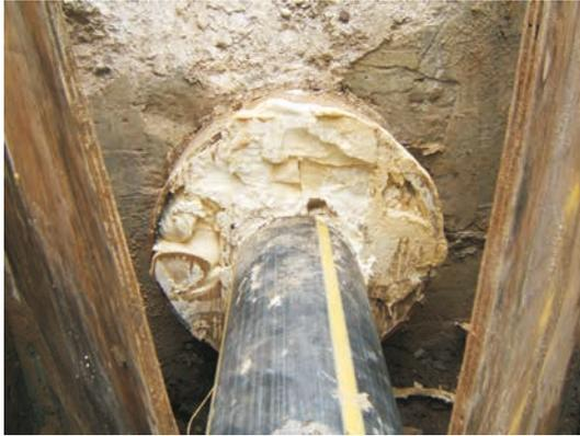
Figure 4.59 **Conduite de gaz sous haute pression en polyéthylène (PE) dans un fourreau en acier – intégrée à un seuil en béton – rempli avec une mousse expansive.**
