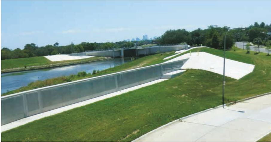
Figure 3.149 **Transition en terme de géométrie de la digue : changement de section transversale entre une digue et un mur antisubmersions, Nouvelle-Orléans, Louisiane, États-Unis**
