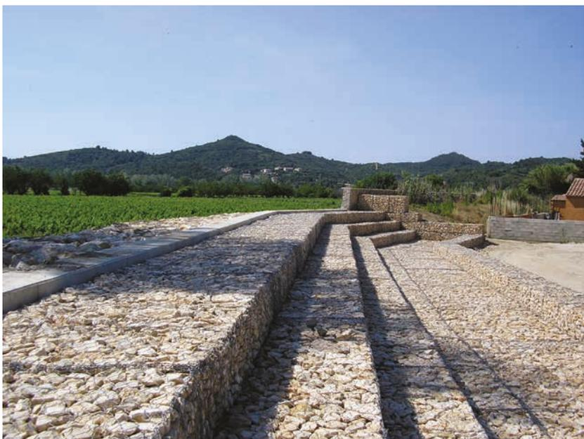
Figure 9.125 Barrage en gradins de gabions en aval de Comps, France
