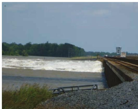
Figure 9.144 **L'ouvrage de contrôle de Morganza évacuant les eaux d'inondation pendant la crue du Mississippi en 2011 ; noter la puissance du flot**
