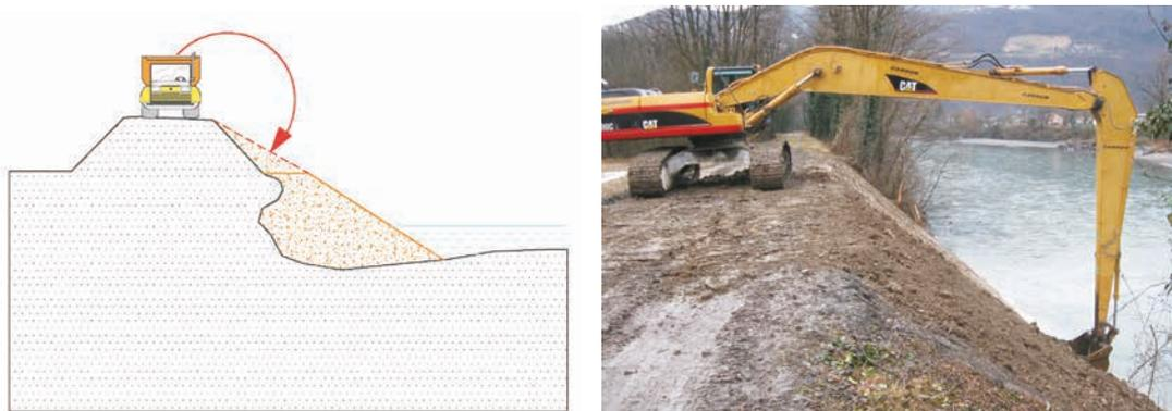
Figure 10.40 Pelle mécanique travaillant à partir de la crête
