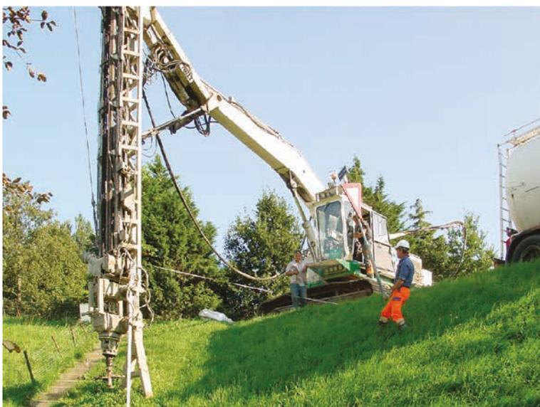
Figure 9.109 **Mélange de sol en profondeur pour faciliter la surélévation d'une digue**
