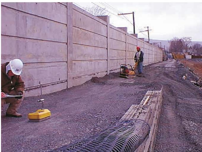
Figure 10.70 **Mur de protection contre les inondations en béton (en arrière-plan) et mur en terre stabilisée par des moyens mécaniques (au premier plan)**
