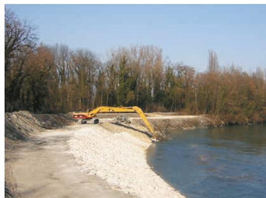
Figure 10.63 **La pelle mécanique met en place les enrochements apportés par les camions**
