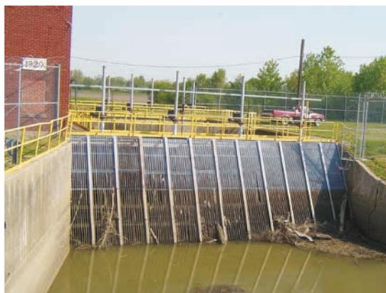
Figure 3.138 **Dégrilleur de station de pompage**
