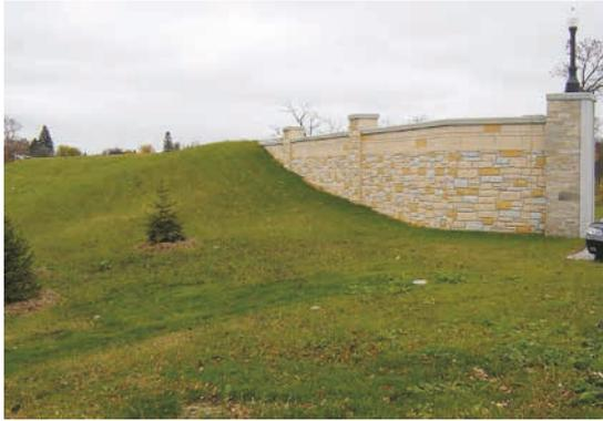
Figure 4.61 **Transition entre un mur contre les inondations en une digue**
