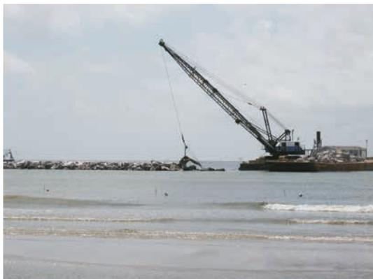
Des opérations de dragage se sont déroulées au large, juste à proximité de l'implantation du projet, et ont nécessité que les matériaux sableux soient acheminés par conduites vers le site du projet à partir des dragues situées en mer (cf. figures 10.44 et 10.45).
