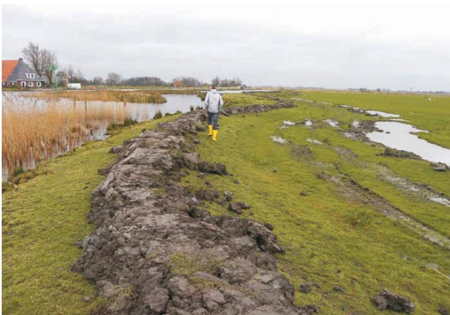
Figure 6.22 **Rehaussement du niveau de crête par remblai (argile) non revêtu**
