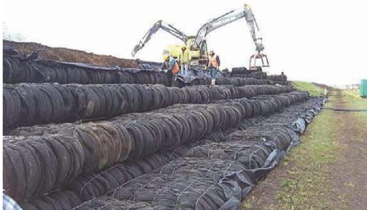
Figure 9.108 **Mise en place terminée sur une section de digue**
