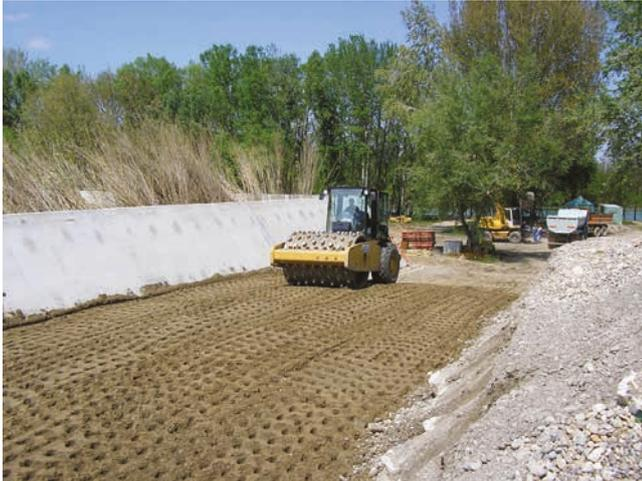
Figure 9.67 **Compactage du matériau de remplissage dans la zone de transition contre le mur anti-crue**
