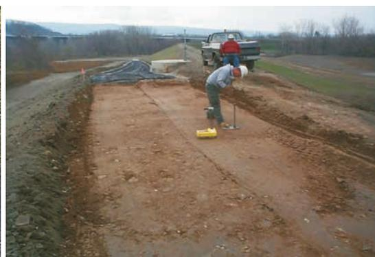
Figure 10.25 **Technicien de laboratoire utilisant un gamma-densimètre pour mesurer la densité de terrain après compactage**
