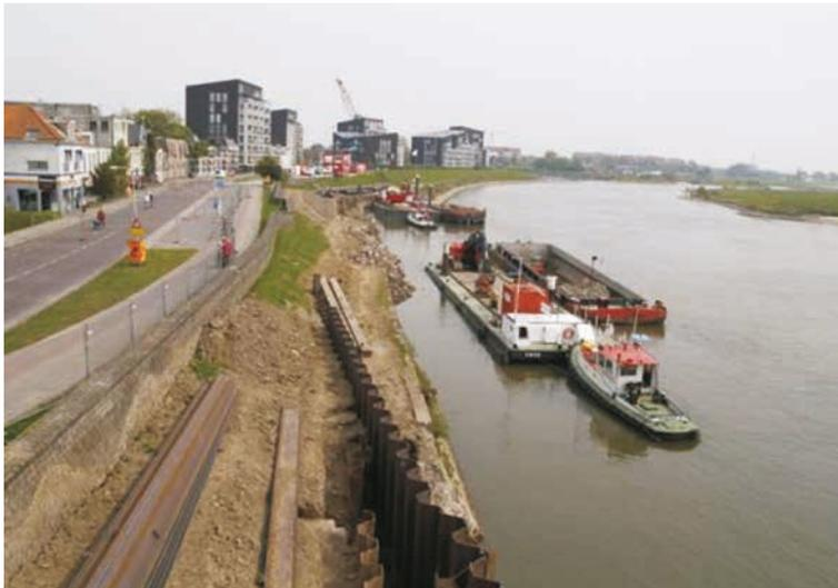
Figure 10.15 **Transport de matériaux sur l'Yssel dans le cadre de la reconstruction du quai Pothoofd à Deventer, aux Pays-Bas**
