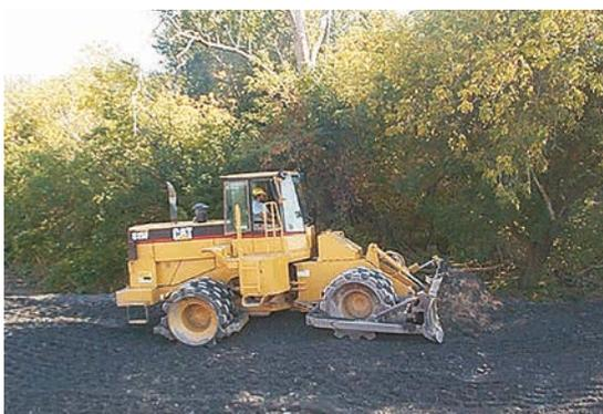
Figure 10.24 **Vérification du nombre de passages nécessaires d'un compacteur autotracteur pour obtenir la bonne densité. Ce type de machine compte pour deux passages, puisqu'il présente des rouleaux de compactage sur les deux essieux**
