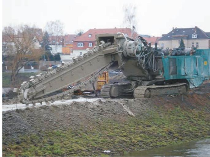
Figure 10.52 Technique de « soil-mixing » sur une digue. La lame de la machine tranche le sol et assure le transfert et le mélange du liant hydraulique en suspension
