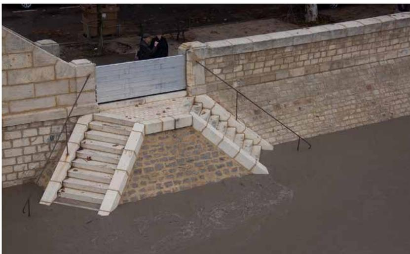
Figure 3.14 **Batardeau antisubmersion sur un accès**
