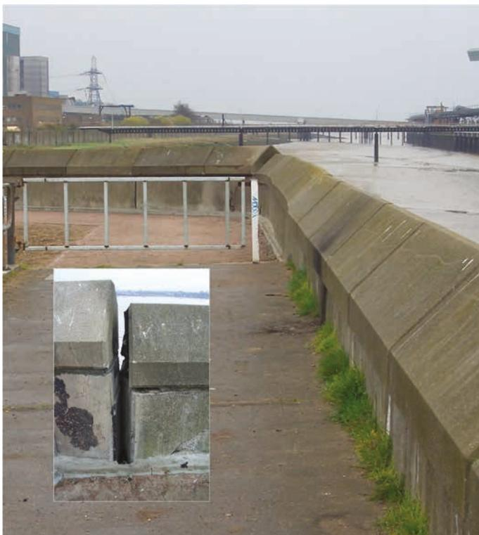
Figure 9.148 **Mouvement différentiel entre des éléments préfabriqués de mur de crête**
