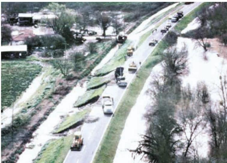
Figure 9.51 Rupture du talus de la digue de Natomas induite par des niveaux de pression interstitielle élevés, lors d'épisodes de hautes eaux dans le fleuve Sacramento, Californie, États-Unis (source : Maire Perlea, USACE)
