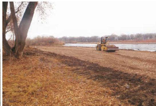
Figure 10.23 **Compactage d'un remblai imperméable par l'utilisation d'un rouleau à pieds de mouton, de façon à déterminer l'épaisseur acceptable de chaque couche et le nombre de passages nécessaires pour obtenir la bonne densité**
