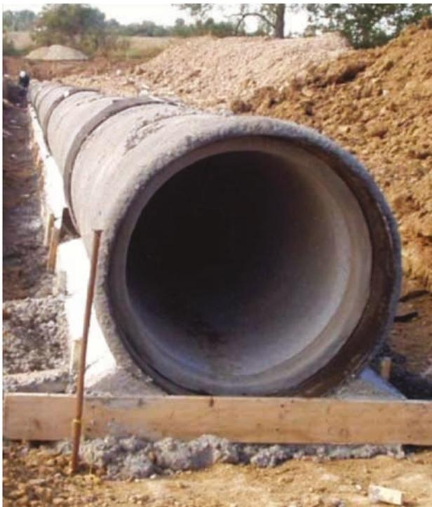
Figure 9.160 **Tuyau préfabriqué en béton supporté par un lit bétonné**
