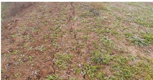
Figure 4.38 Fissures préoccupantes en crête de digue. Des mesures préventives, comme l'installation d'un système de drainage, sont recommandées (avec l'aimable autorisation d'Y. Nedelec)
