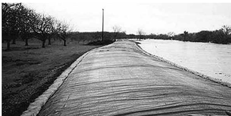
Figure 6.33 **Utilisation d'un déversoir d'urgence**
