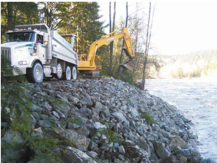
Figure 6.28 **Construction d'un revêtement en enrochement**
