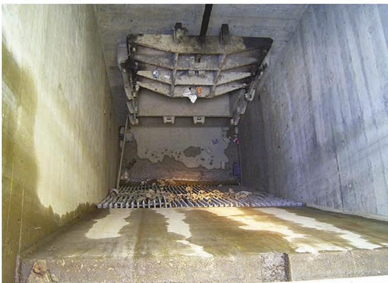
Figure 3.121 **Porte clapet dans une structure encastrée**
