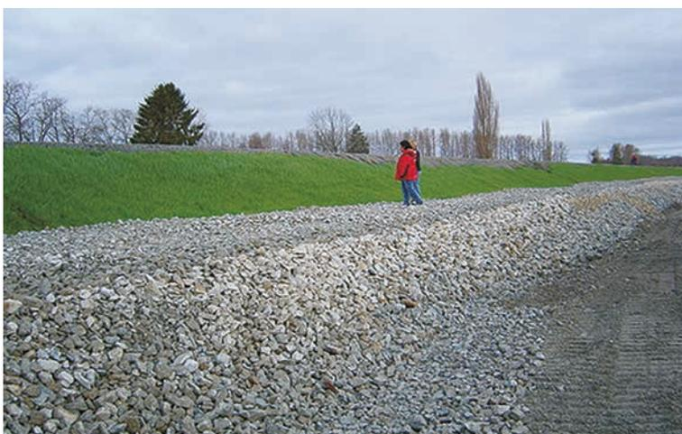
Figure 6.37 **Berme construite côté terre, destinée à réduire les infiltrations**
