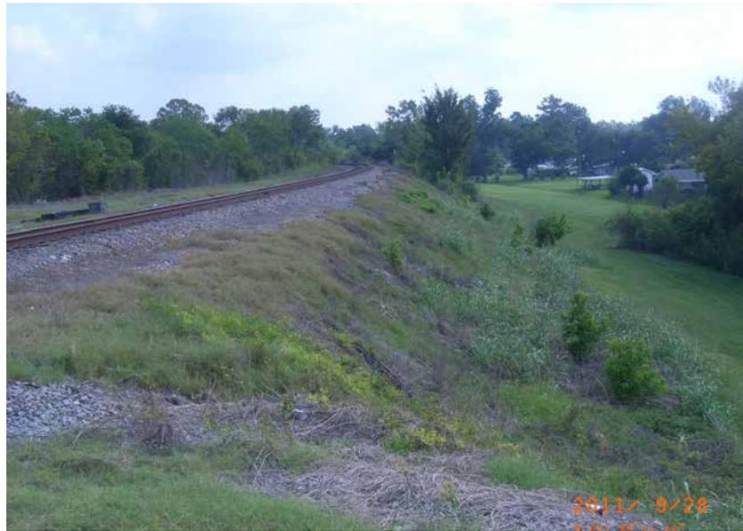
Figure 3.18 **Remblai ferroviaire servant de ligne de défense**
