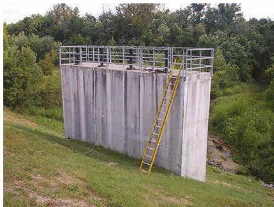
Figure 3.120 **Structure de porte encastrée**
