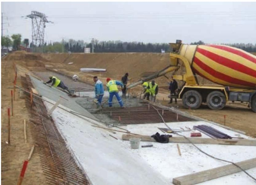
Figure 9.118 **Construction de dalles de déversoir en béton armé**
