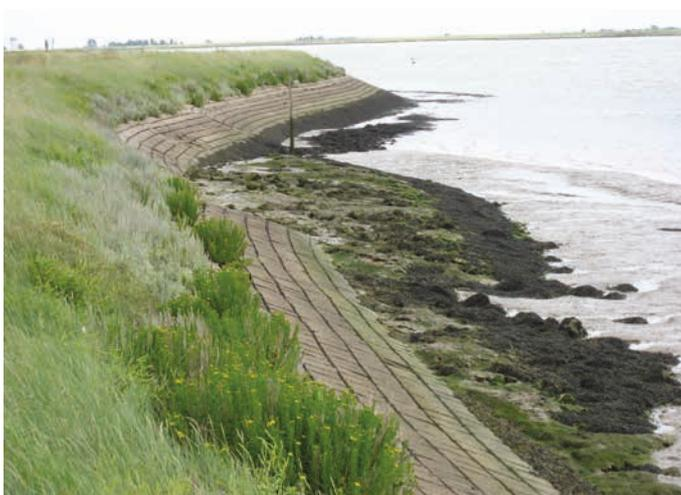
Figure 9.28 **Protection en blocs de béton**
