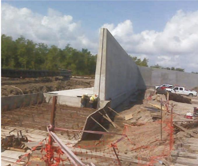
Figure 10.68 **Mur en béton de protection contre les inondations**
