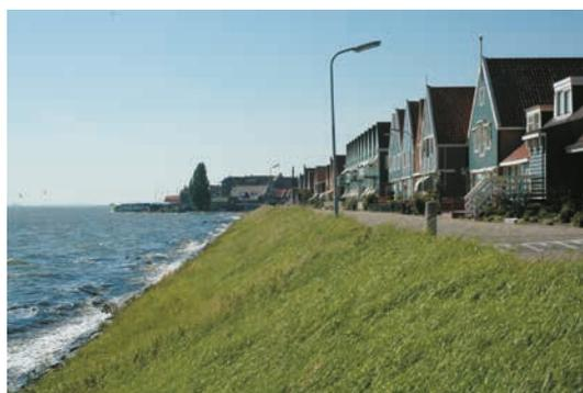
Figure 4.5 Habitations avec des rez-de-chaussée et des sous-sols situés dans l'emprise de la digue
