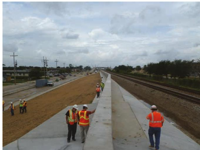
Figure 9.147 **Partie du mur enT de LPV 105 terminée**
