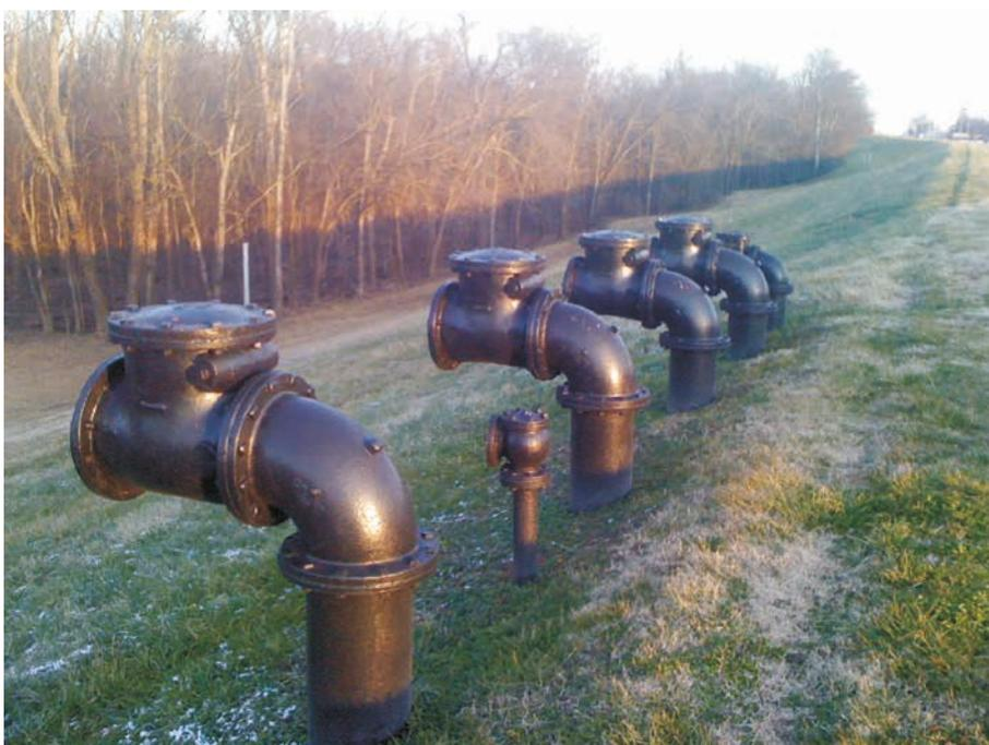
Figure 3.136 **Valves de ventilation sur une crête de digue**
