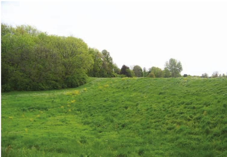
Figure 3.150 **Transition en terme de géométrie : transition entre une digue et un flanc de colline, Columbia, Illinois, États-Unis**
