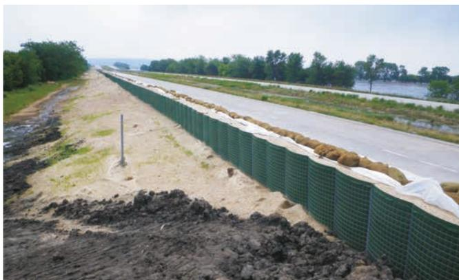
Figure 6.52 Exemple de caissons perméables remplis
