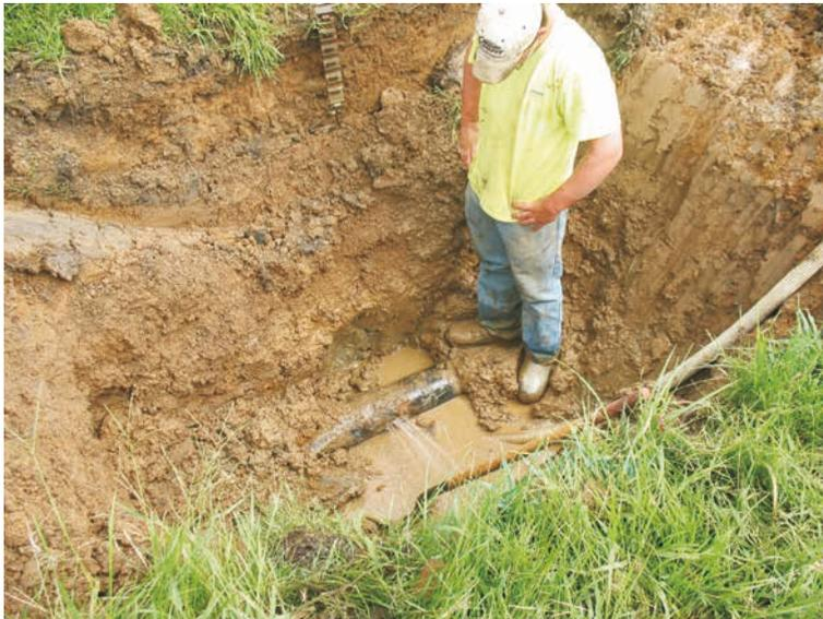
Figure 4.58 **Réparation en tranchée ouverte d'une canalisation d'alimentation en eau placée à l'intérieur de la digue présentant des fuites (réparations techniques les moins souhaitables en raison de leur coût et des perturbations du profil de la digue)**
