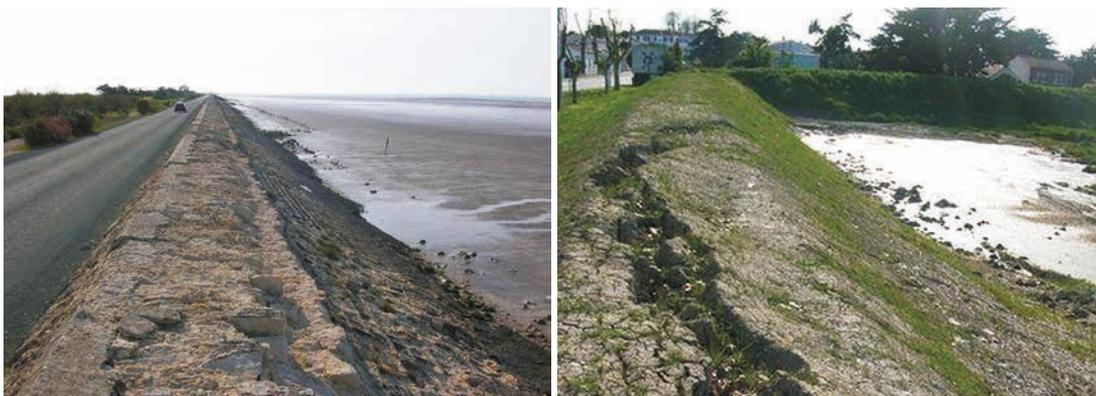
Figure 3.157 **Endommagement par les vagues et glissement rotationnel**
