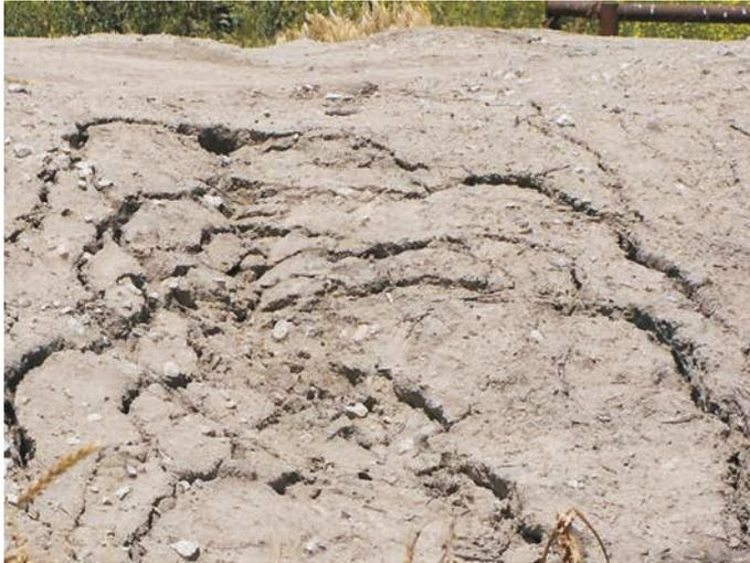
Figure 4.44 Fissures de contrainte dans le talus d'une digue (signe qu'un glissement est en cours)
