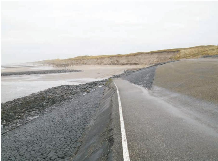
Figure 3.153 **Érosion d'une transition avec une dune, nord de la digue côtière Hondsbossche-en Pettermer Zeewering, Pays-bas**
