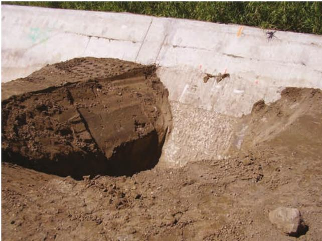
Figure 9.68 **Excavation d'une tranchée perpendiculaire aux percolations**
