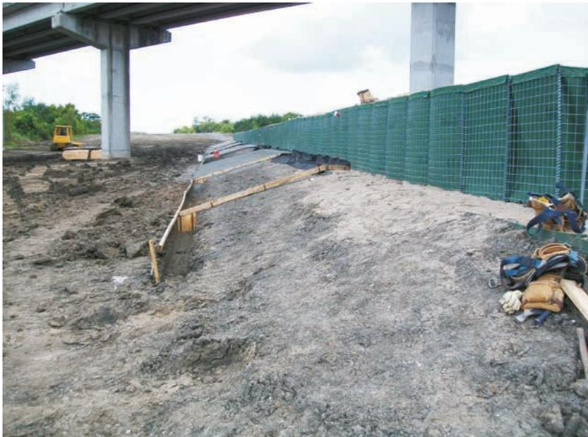
Figure 10.9 **Protection temporaire contre les inondations mise en œuvre pour protéger une communauté adjacente au cours de la reconstruction des protections existantes**
