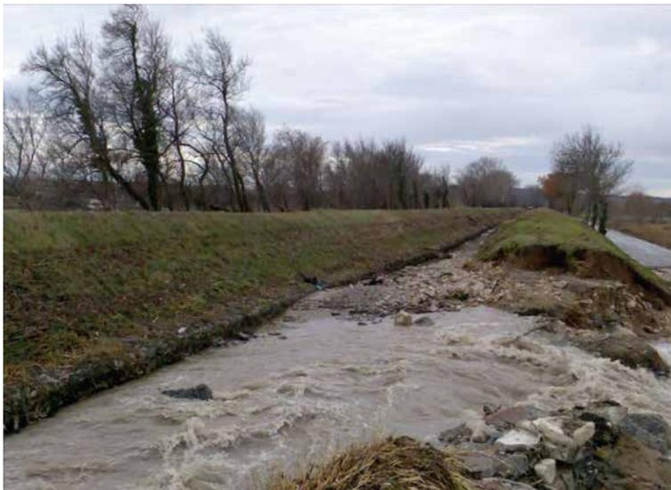
Figure 3.171 **Érosion externe du talus terrestre d'une digue**
