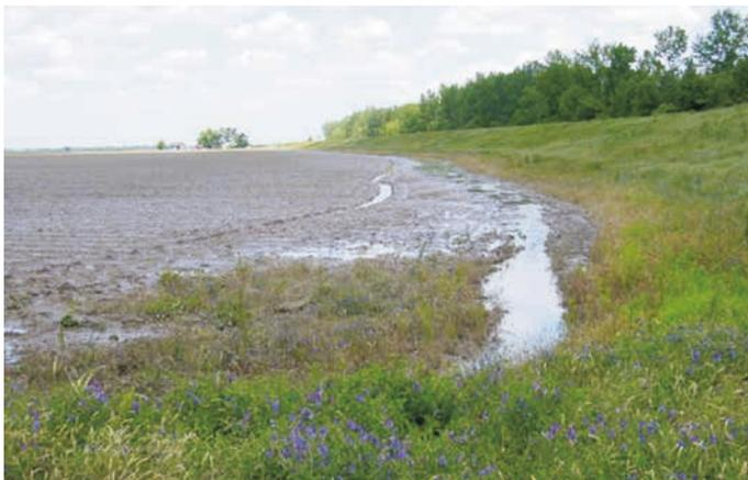
Figure 4.41 Écoulement en pied de digue, côté zone protégée
