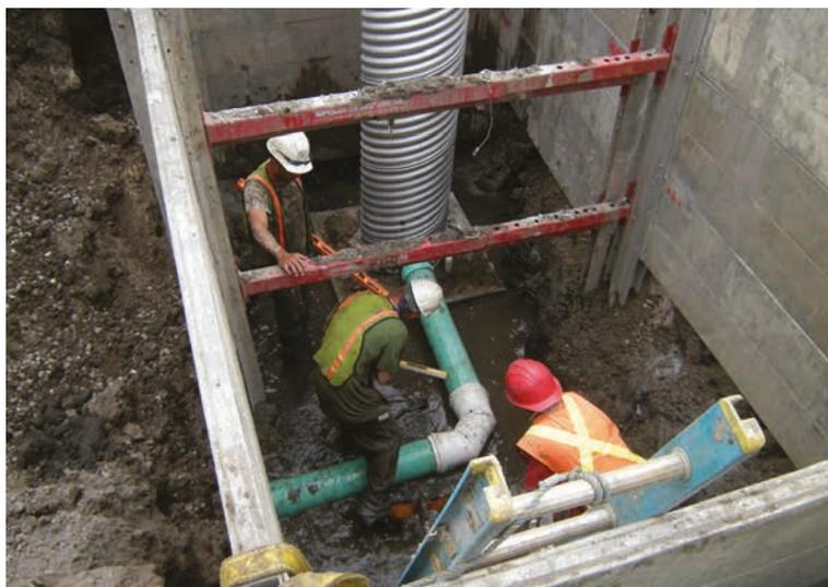
Figure 9.43 **Raccordement du nouveau puits de décompression au collecteur enterré**
