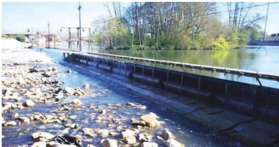
Figure 9.136 **Seuils gonflables à volet métallique à Auxonne**
