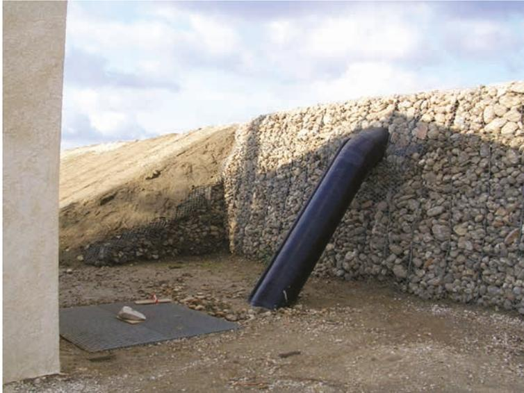
Figure 9.155 **Vue côté terre d'un tuyau traversant le Rhône en France**
