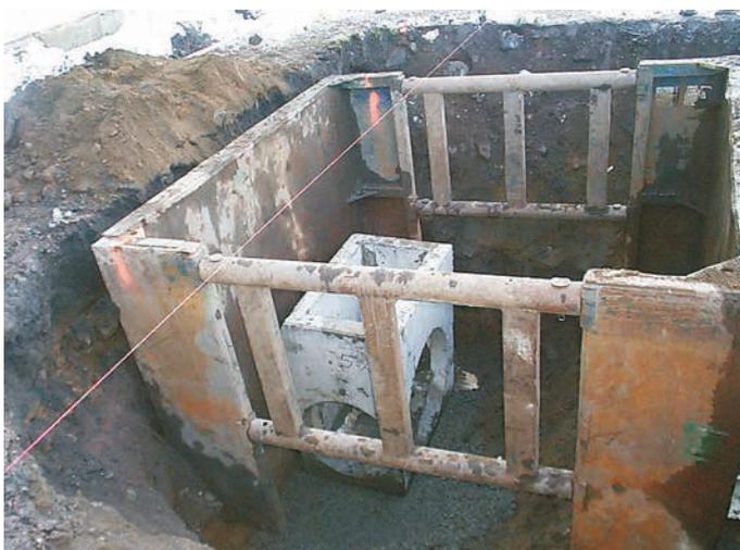
Figure 10.71 **Implantation d'une canalisation d'eaux usées sanitaires avant la construction d'une digue**
