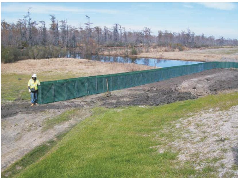
Figure 10.8 Exemple de protection temporaire contre les inondations en cours de construction
