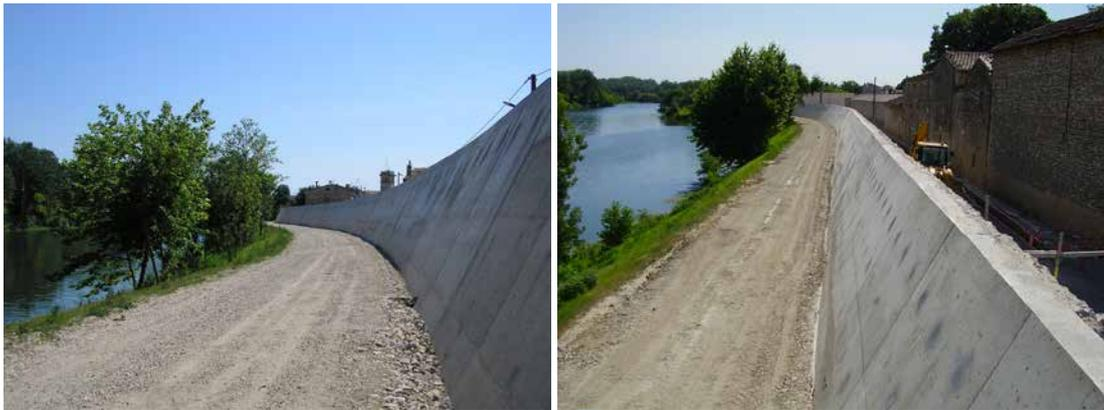
Figure 3.83 Surélévation de crête de digue par mur en béton
