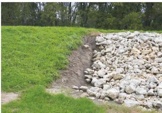
Figure 4.63 **Transition entre une digue et un enrochement.**
