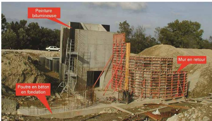
Figure 9.164 **Construction de l'ouvrage hydraulique traversant à Aramon**
