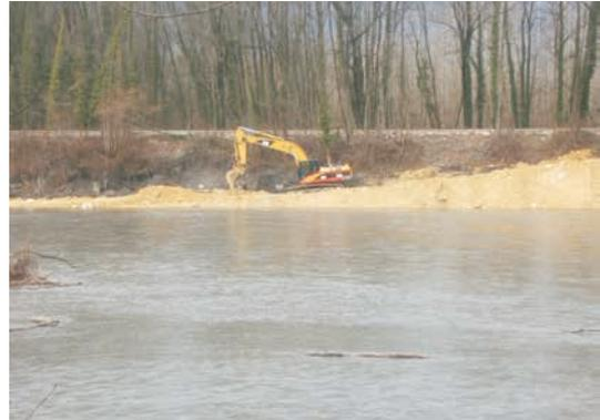
Figure 10.37 La pelle mécanique (travaillant sur le talus) utilise les matériaux pour façonner le profil
