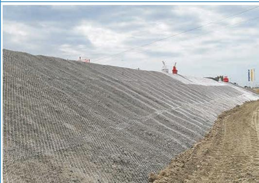
Figure 10.31 **Mise en place d'un grillage de protection sur la digue**
