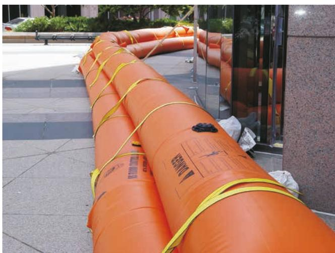
Figure 6.51 **Mise en place du système « Tiger Dam »**
