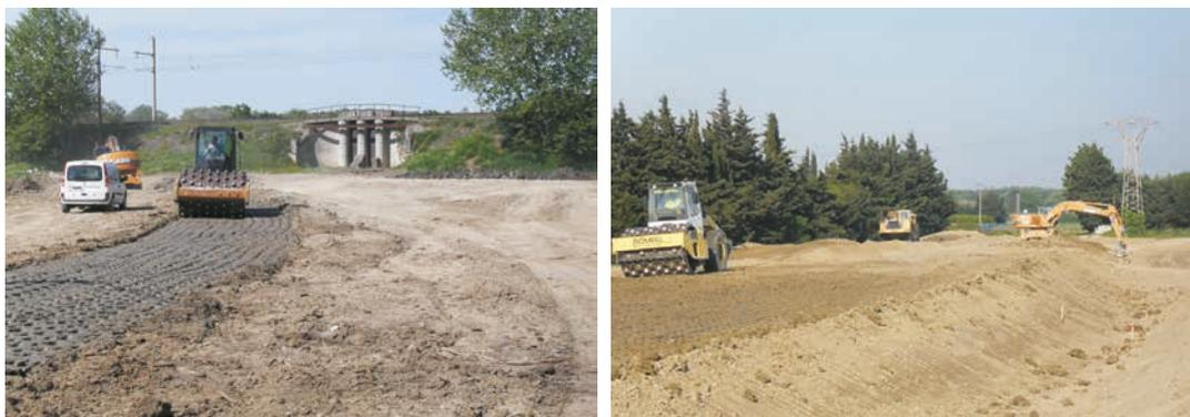
Figure 10.30 **Remblaiement de la tranchée d'ancrage et du corps de la digue avec des matériaux imperméables**
