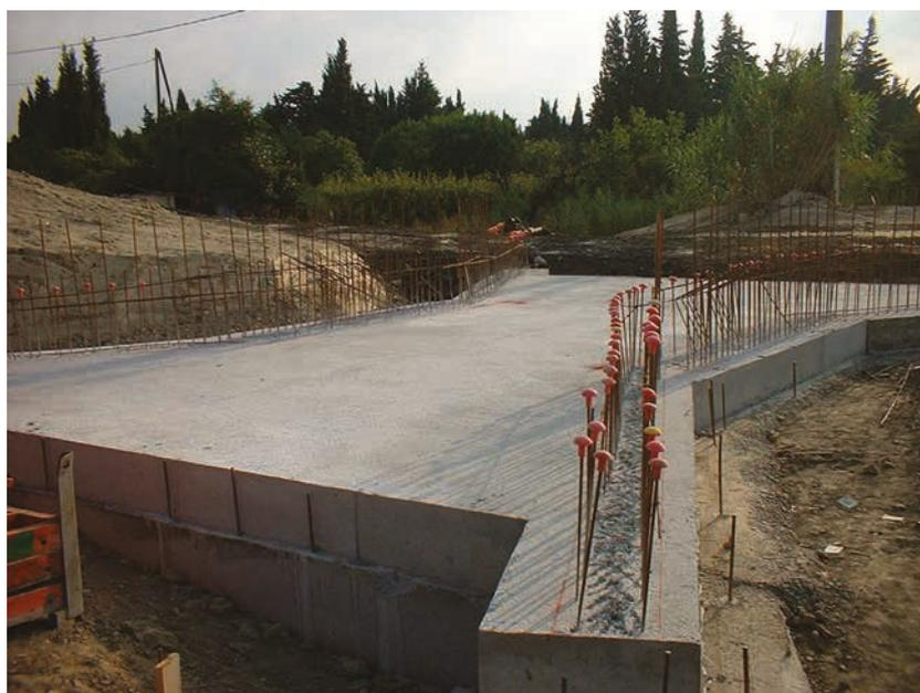
Figure 9.71 **Dalle et poutres en béton coulées directement dans les excavations, digue d'Aramon, sud de la France**
