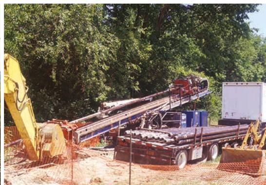
Figure 3.144 **Plate-forme de forage dirigé horizontal**
