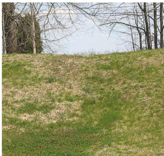
Figure 5.39 **Dépression au niveau de la crête de digue, directement au-dessus d'une conduite en tôle ondulée détériorée**
