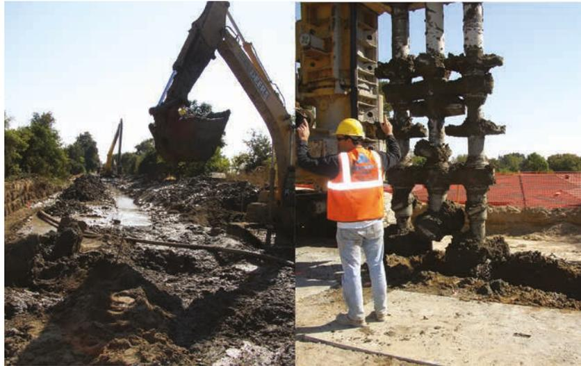
Figure 9.88 **Construction de barrière anti-infiltrations le long de l'axe de la digue, Sacramento, CA**
