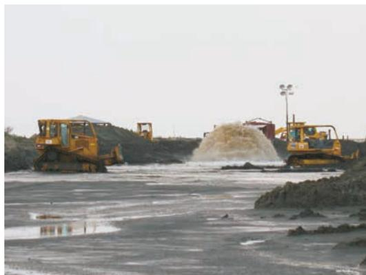
Figure 10.45 **Opérations de mise en place de sable à l'exutoire de la canalisation de refoulement**
