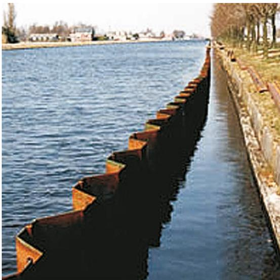
Figure 6.25 **Utilisation de palplanches pour rehaussement d'une digue**
