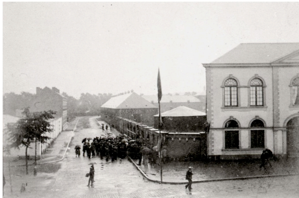
Figure 42 - L'ancienne caserne Léopold, rue de Nimy, Mons, architecte Charles-François Sury, 1838-1841.
