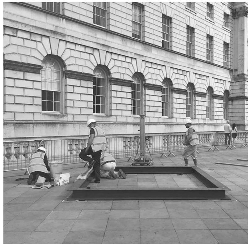
Figures 59a - Chantier de la Silent Room V0.2, pause de la structure fondatrice (poutres IPN calées sur la trame de la terrasse)
