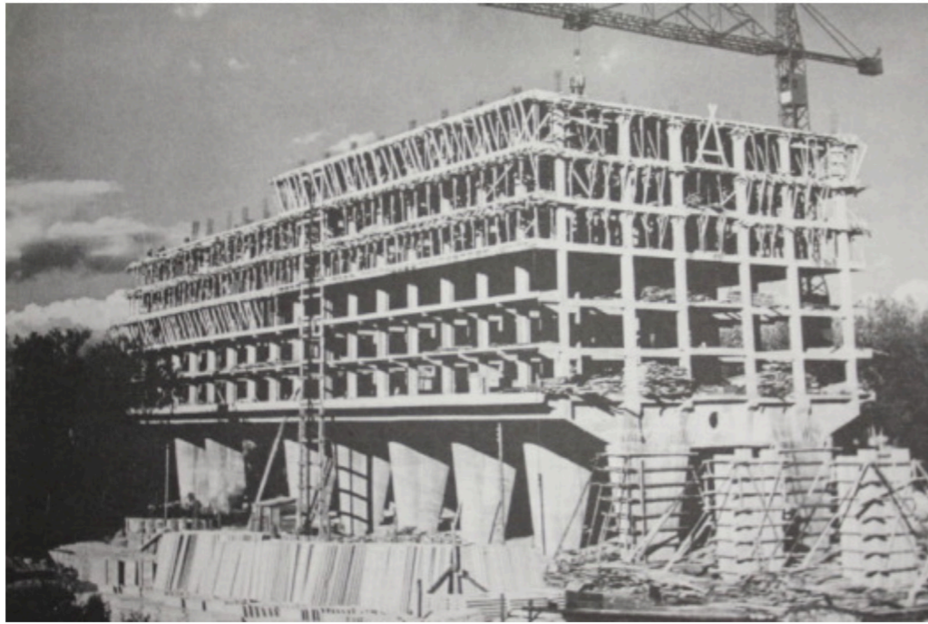
Figure 9a - Le Corbusier, Unité d'habitation de Marseille, système poteaux-poutres en béton, 1947 - 1948.
